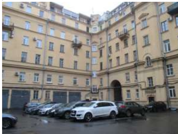
Фото 2. Вид здания, в котором расположен Объект оценки
