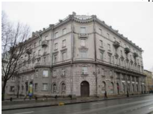
Фото 1. Вид здания, в котором расположен Объект оценки
