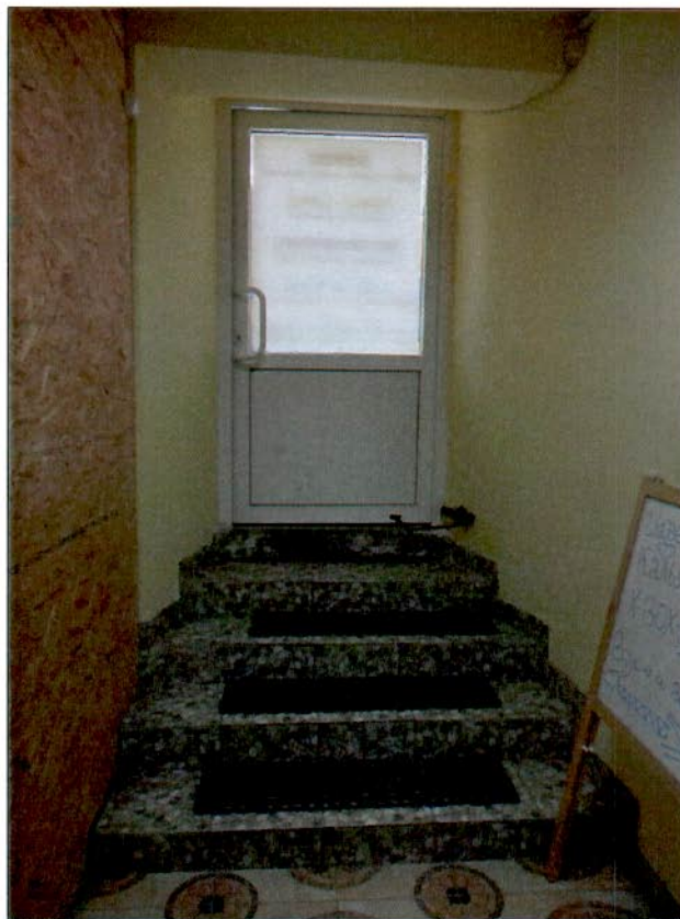
26. Лестница помещения в уровне цокольного этажа (лицевой корпус по Гороховой улице).
