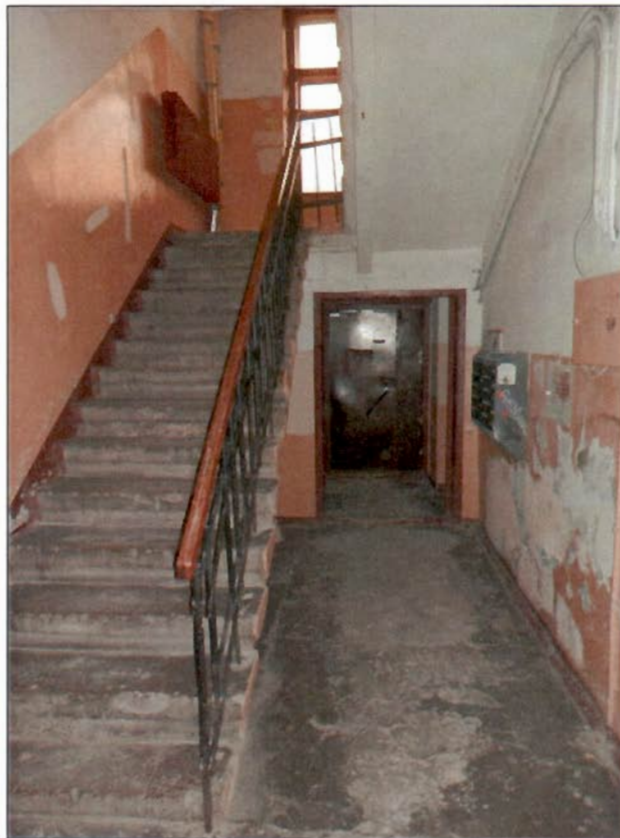
24. Двухмаршевая лестница (отдельностоящий дворовый флигель)
