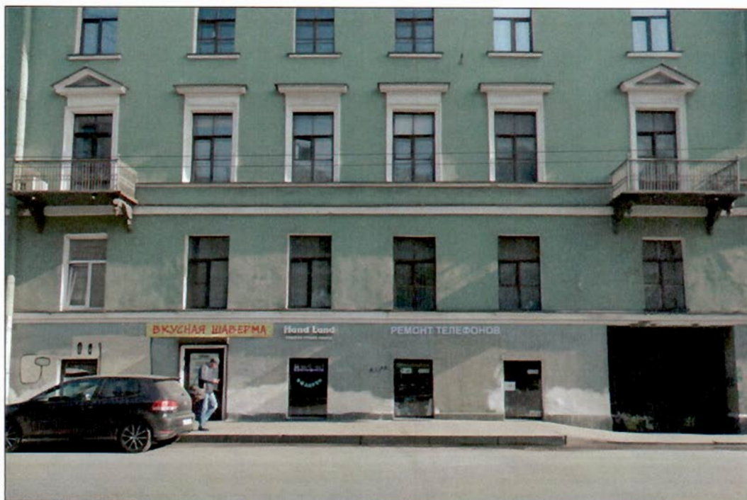
3. "Дом Кукановой А. (Кладо Л.М.)". Лицевой фасад со стороны Гороховой улицы. Фрагмент.
