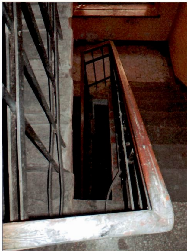
25. Двухмаршевая лестница (отдельностоящий дворовый флигель)
