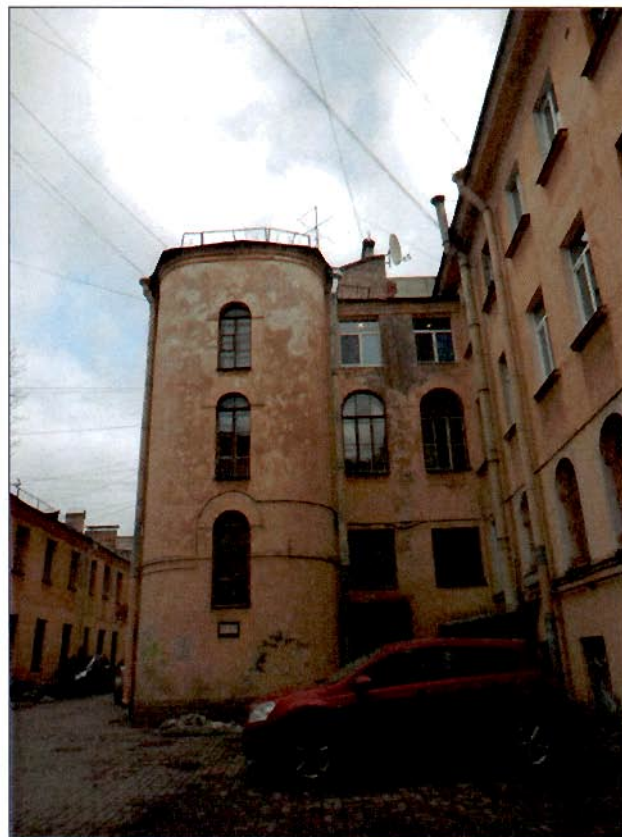
6. "Дом Кукановой А. (Кладо Л.М.)". Западный фасад южного дворового корпуса.
