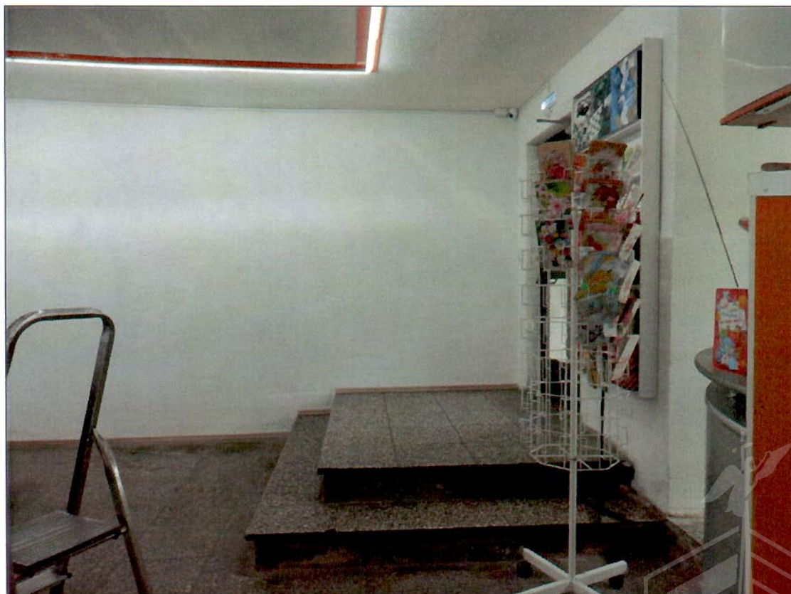
27. Лестница помещения в уровне цокольного этажа (лицевой корпус по наб. р. Фонтанки).
