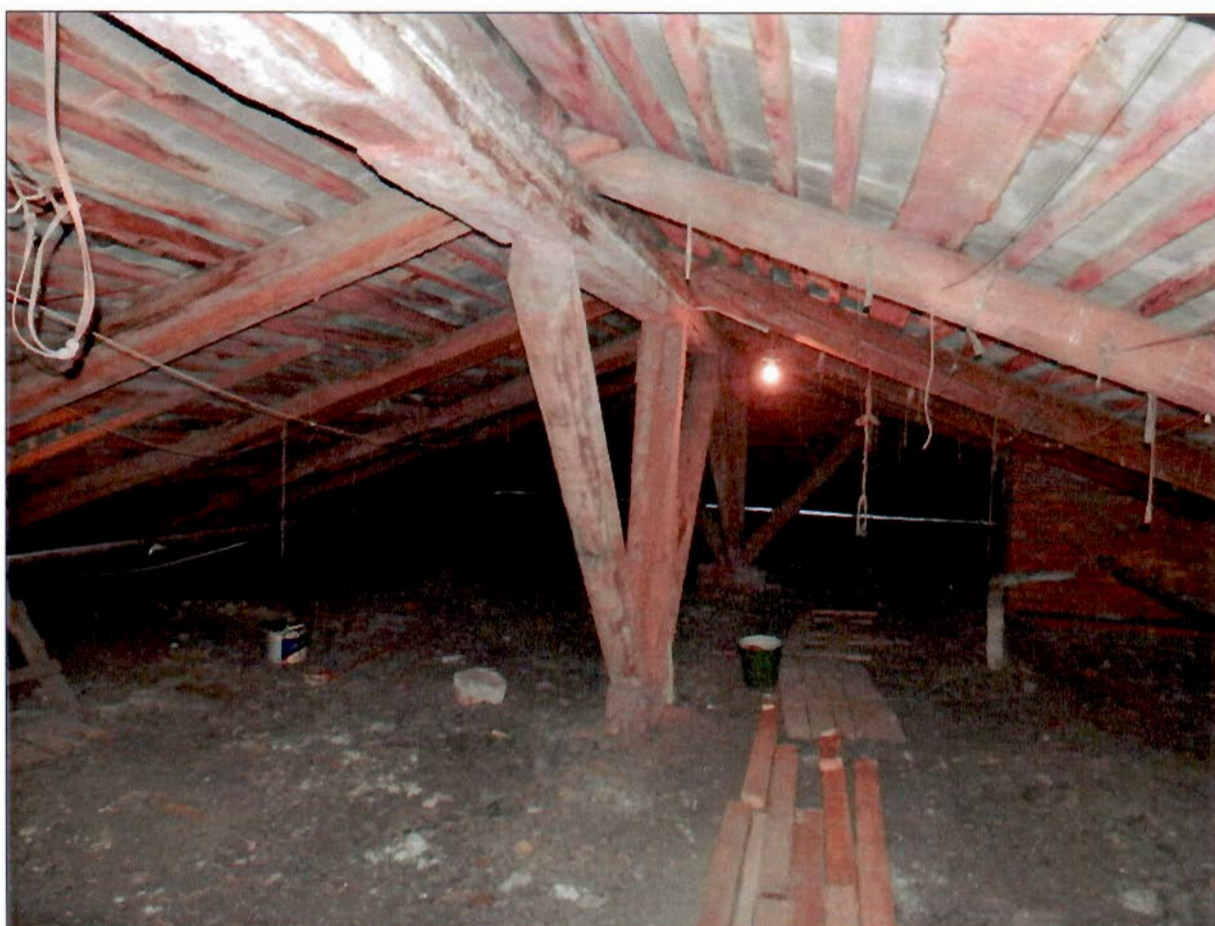
19. Отдельностоящий дворовый флигель. Стропильная система.
