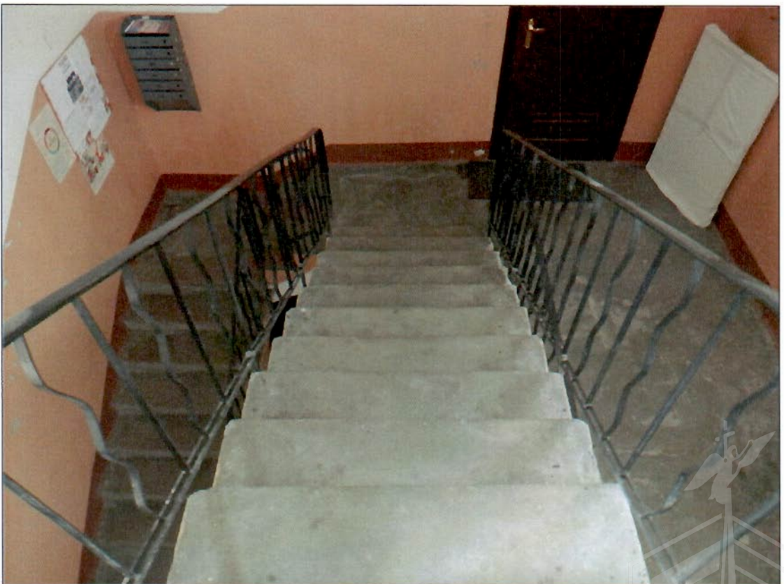
23. Двухмаршевая лестница (лицевой корпус по Гороховой улице).
