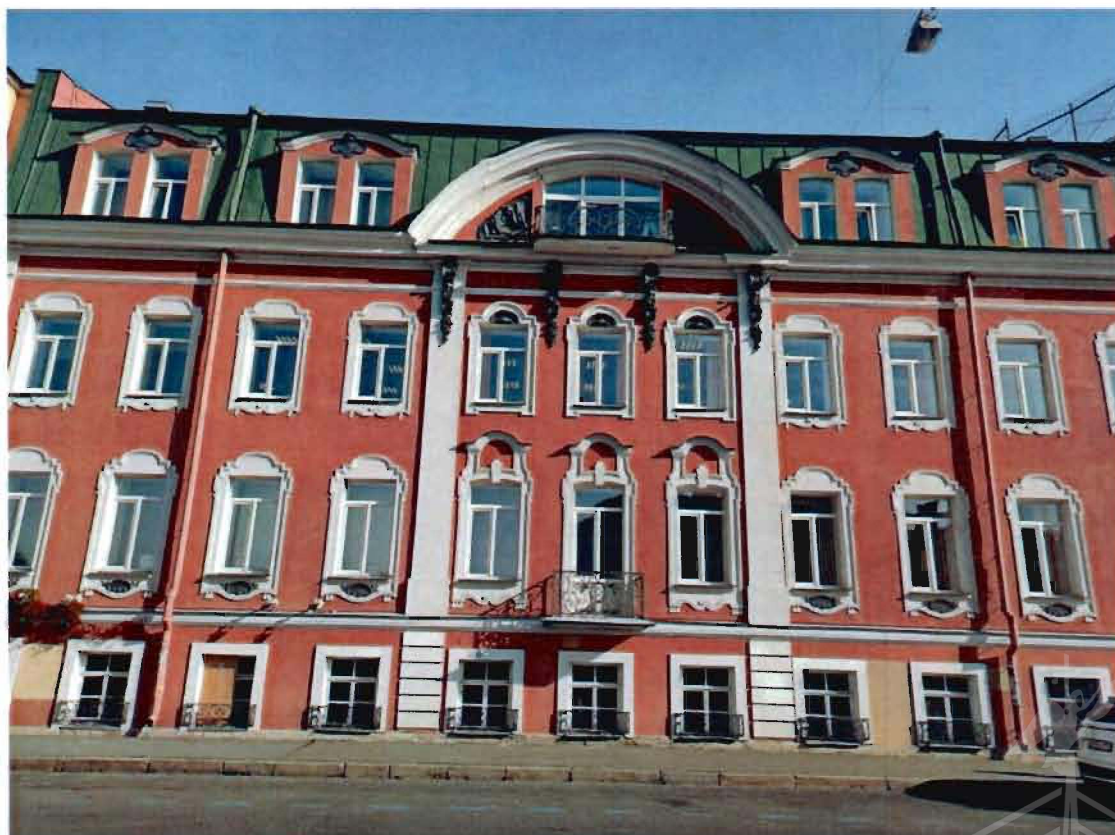
3. Лицевой фасад южного корпуса (Фотография от 27.09.2023).
