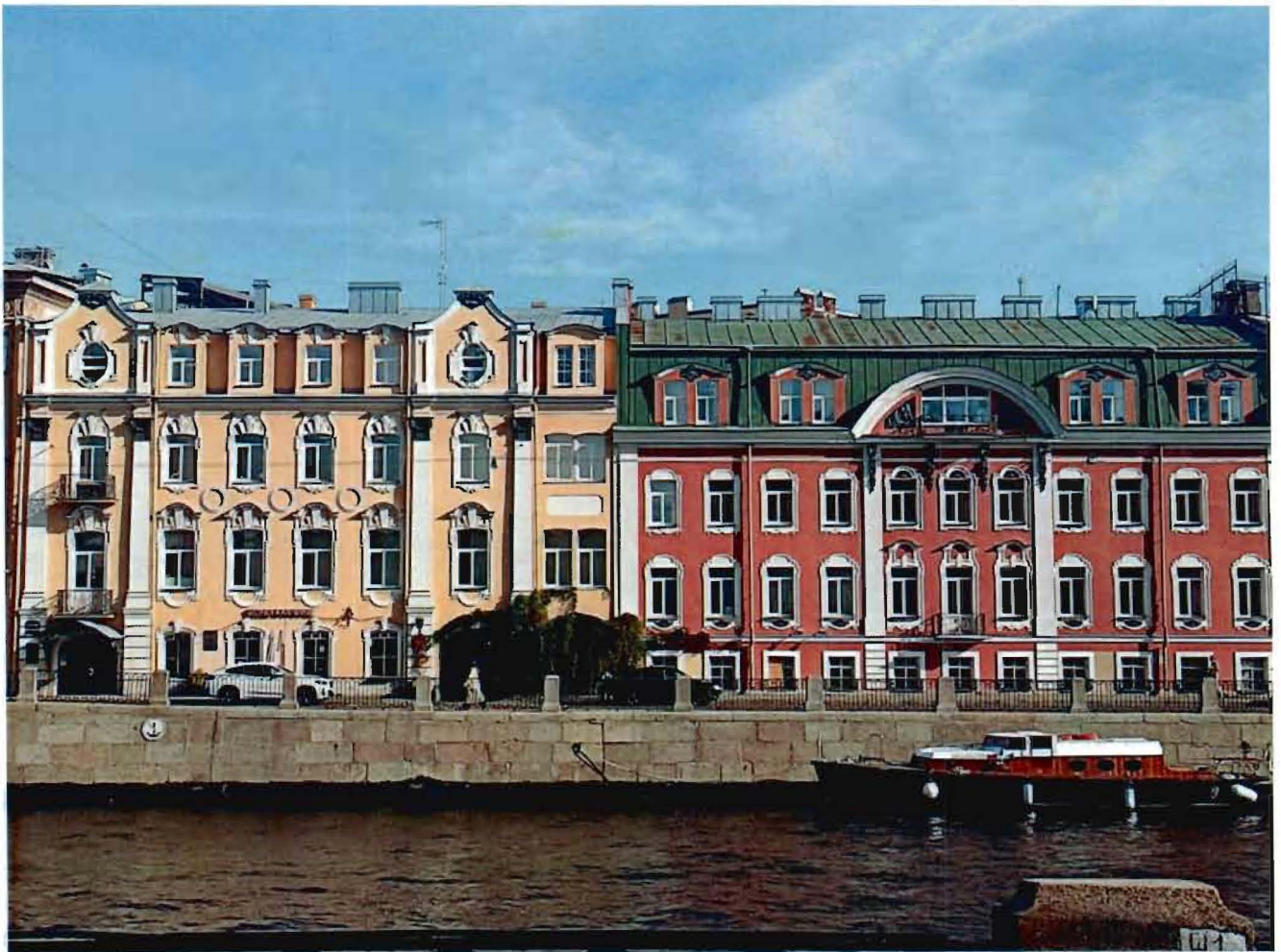
1. Лицевой фасад, вид с противоположного берега р. Фонтанки (Фотография от 27.09.2023).
