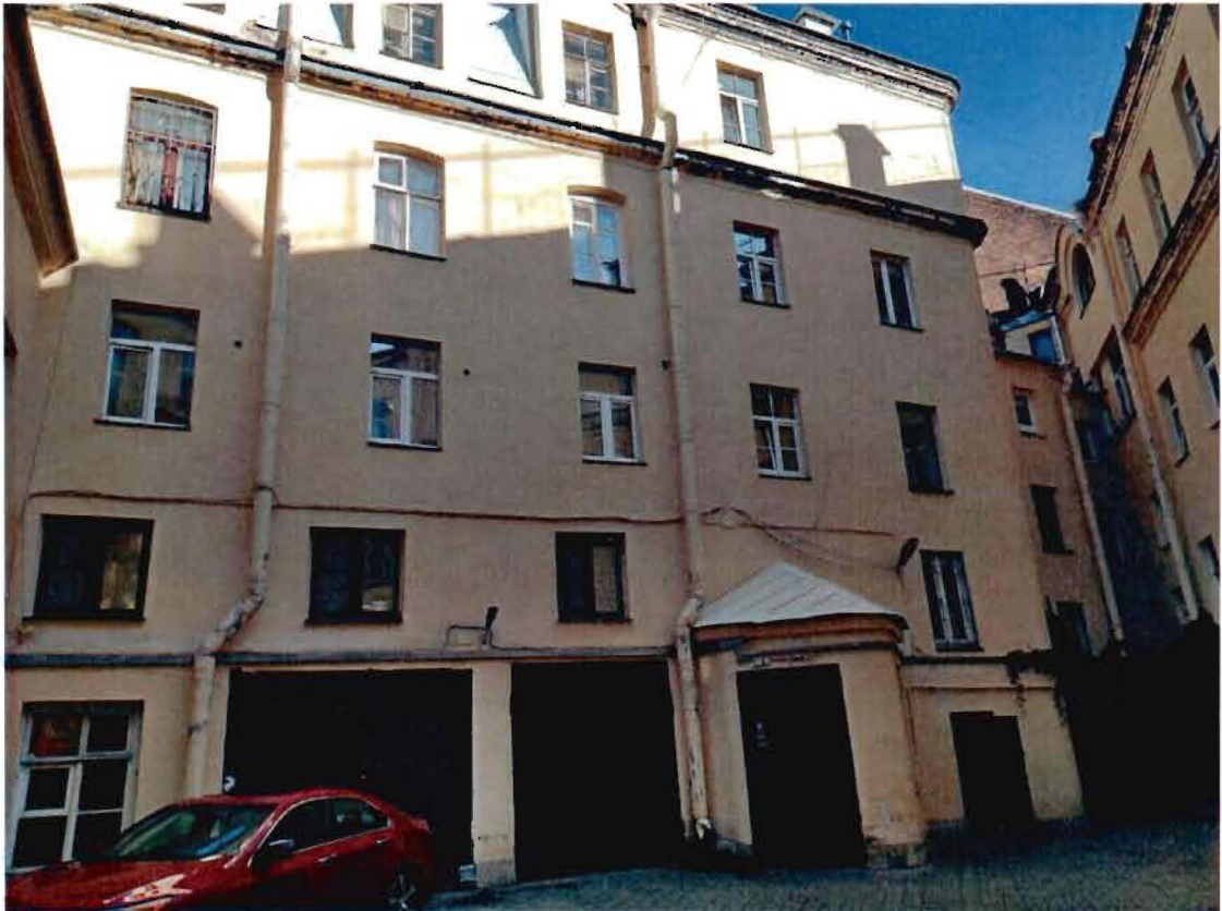
10. Северный фасад южного двора (Фотография от 10.10.2023).
