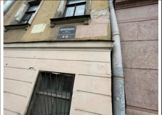
Фото 16. Адрес Объекта оценки
