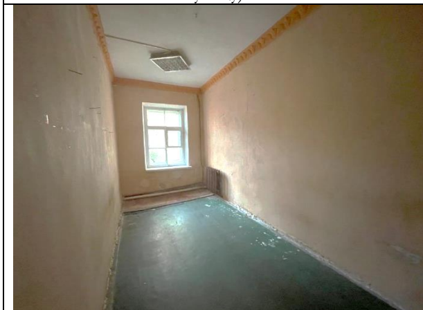
Фото 33. Типичное состояние Объекта оценки
