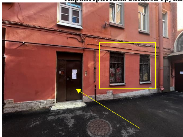
Фото 5. Общий вход со двора и окна Объекта оценки
