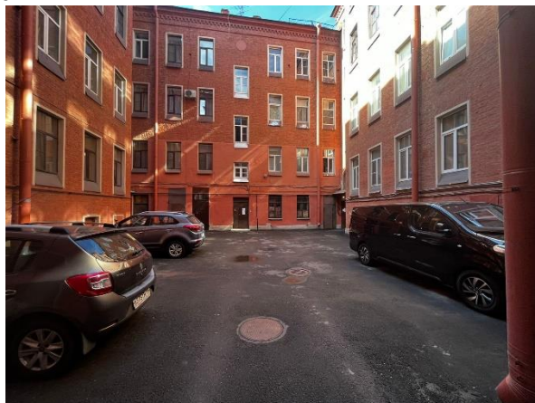
Фото 2. Вид здания, в котором расположен Объект оценки
