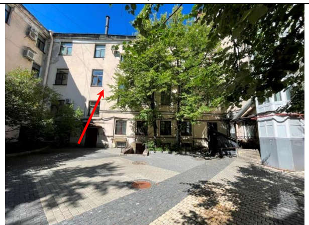
Фото 22. Вид здания расположения Объекта оценки
