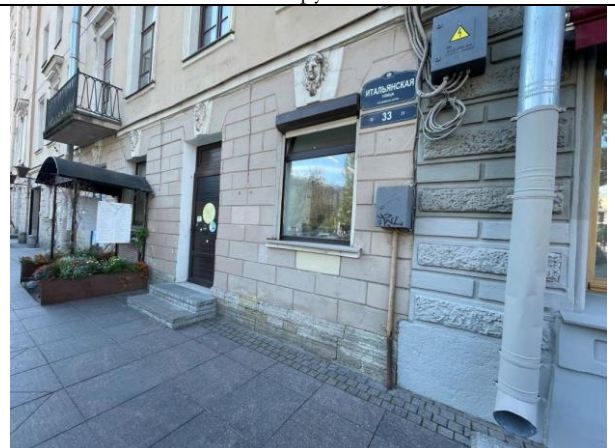
Фото 14. Адрес Объекта оценки
