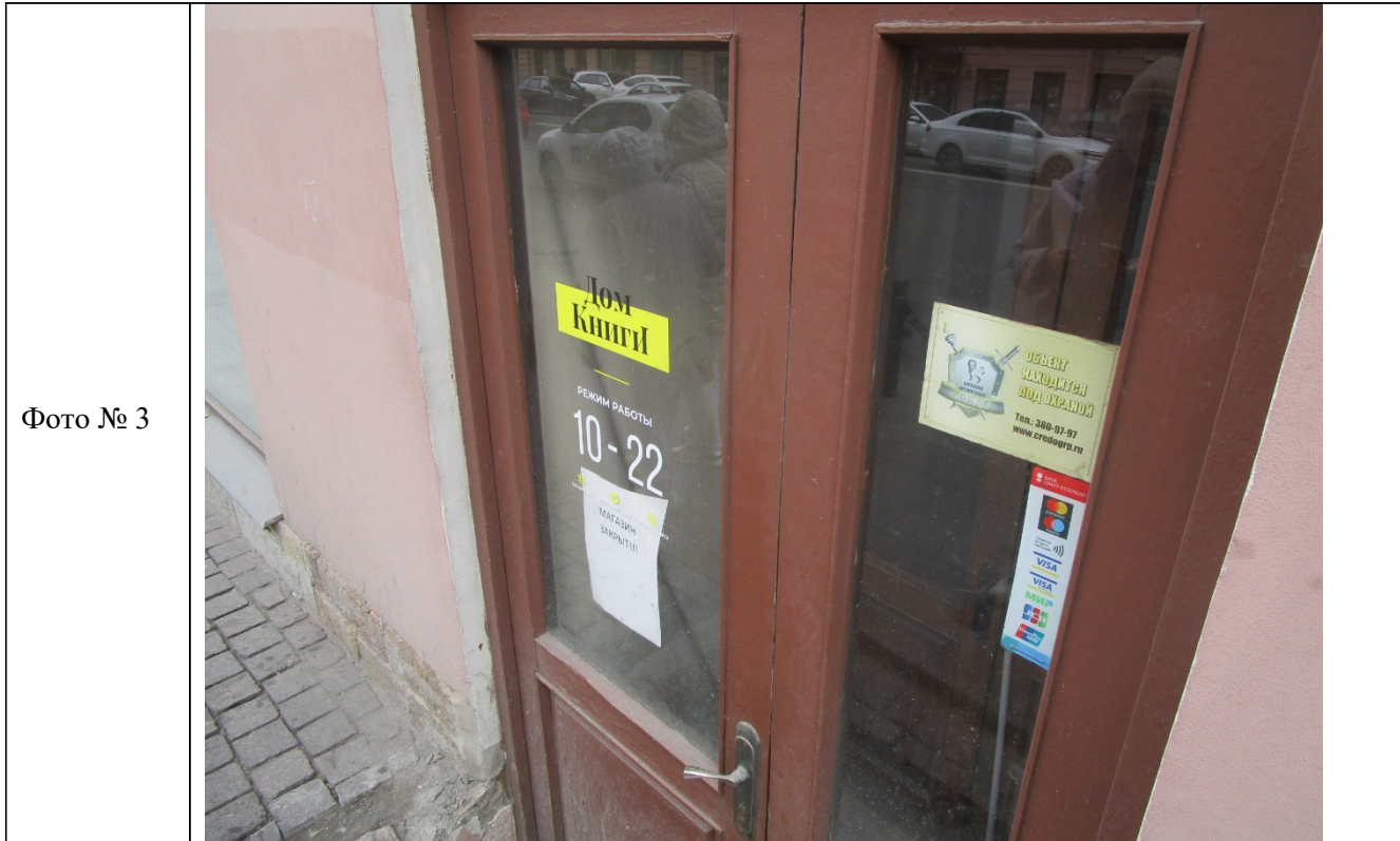
Описание: Вход в Объект
