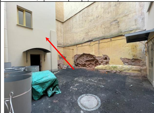
Фото 19. Вид здания Расположения Объекта оценки
