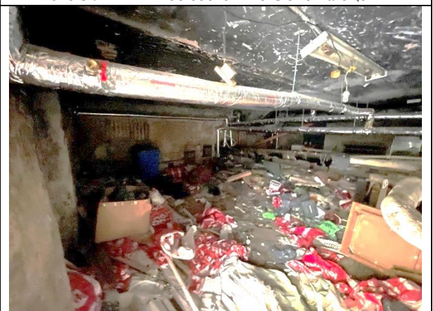
Фото 36. Типичное состояние Объекта оценки
