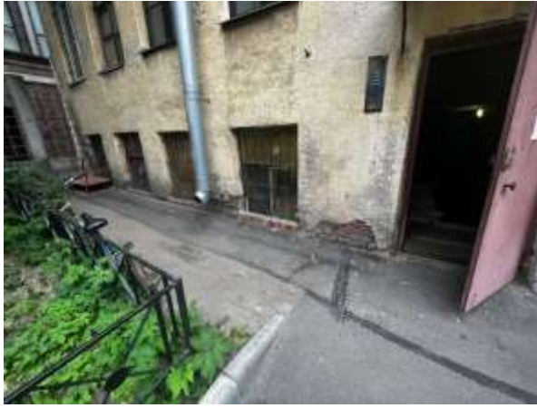
Фото 7. Общий вход со двора и окна
