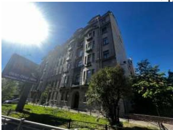
Фото 1. Вид здания, в котором расположен Объект оценки
