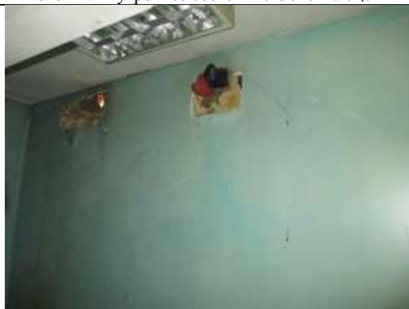
Фото 14. Внутреннее состояние Объекта оценки
