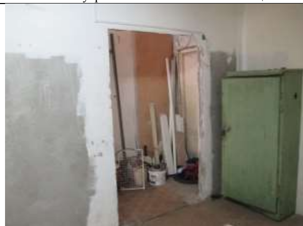
Фото 11. Внутреннее состояние Объекта оценки
