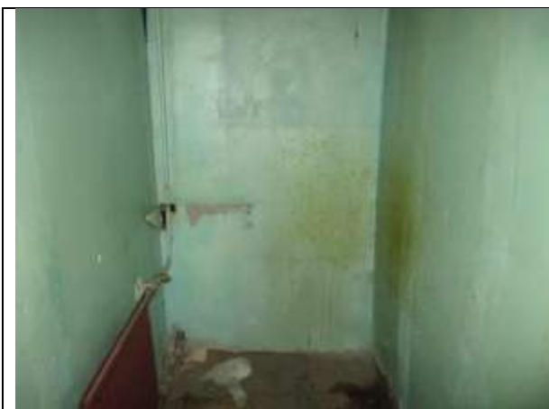
Фото 15. Внутреннее состояние Объекта оценки
