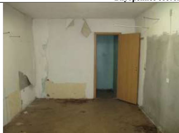
Фото 9. Внутреннее состояние Объекта оценки
