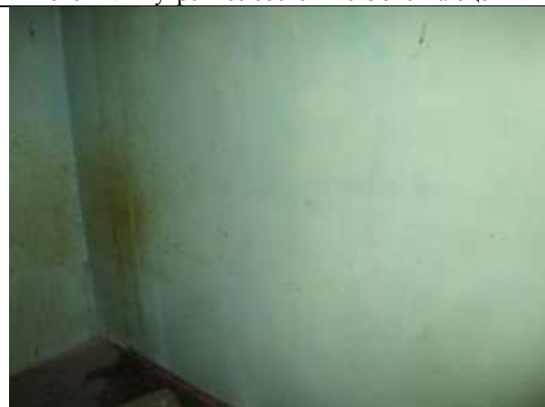
Фото 13. Внутреннее состояние Объекта оценки
