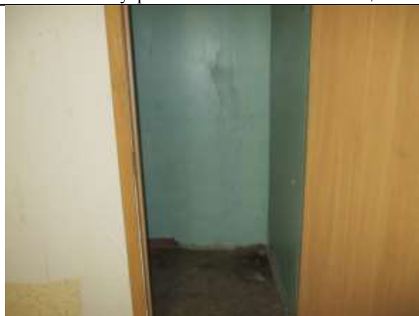
Фото 12. Внутреннее состояние Объекта оценки
