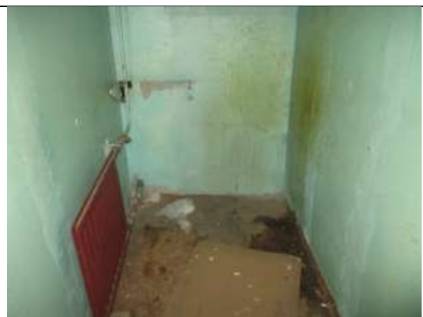
Фото 16. Внутреннее состояние Объекта оценки
