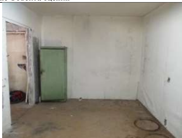
Фото 10. Внутреннее состояние Объекта оценки
