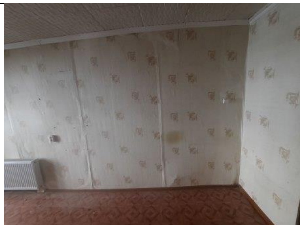
Фото № 16 – Внутреннее состояние помещения
