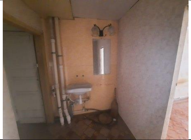
Фото № 8 – Внутреннее состояние помещения
