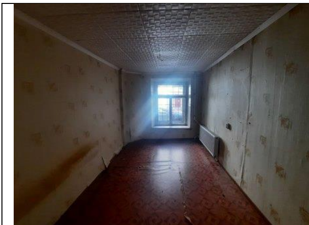
Фото № 15 – Внутреннее состояние помещения
