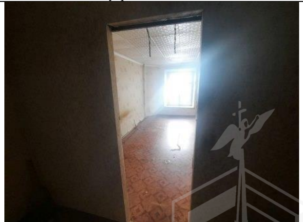
Фото № 14 – Внутреннее состояние помещения
