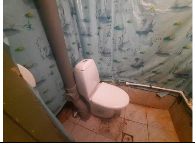
Фото № 10 – Внутреннее состояние помещения
