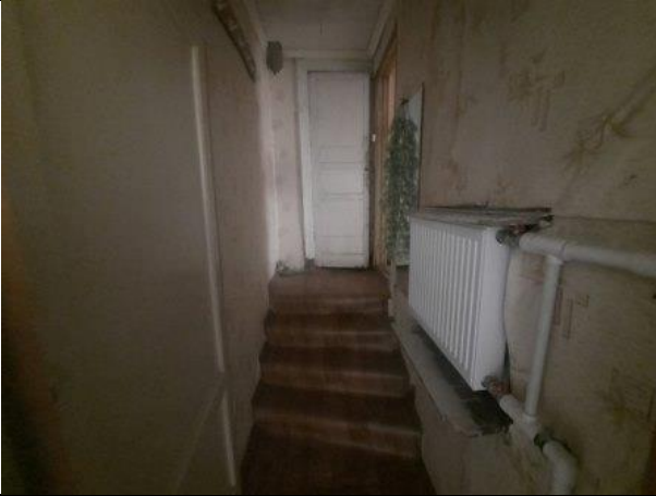
Фото № 7 – Внутреннее состояние помещения
