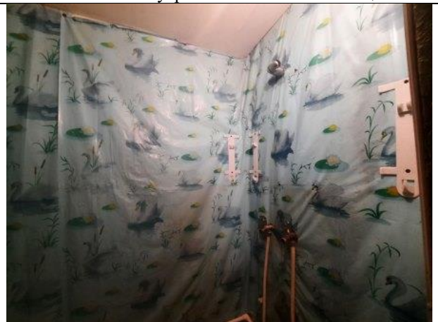
Фото № 12 – Внутреннее состояние помещения
