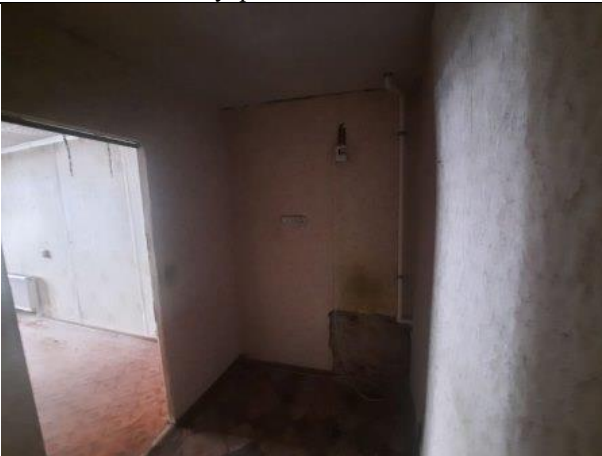
Фото № 13 – Внутреннее состояние помещения
