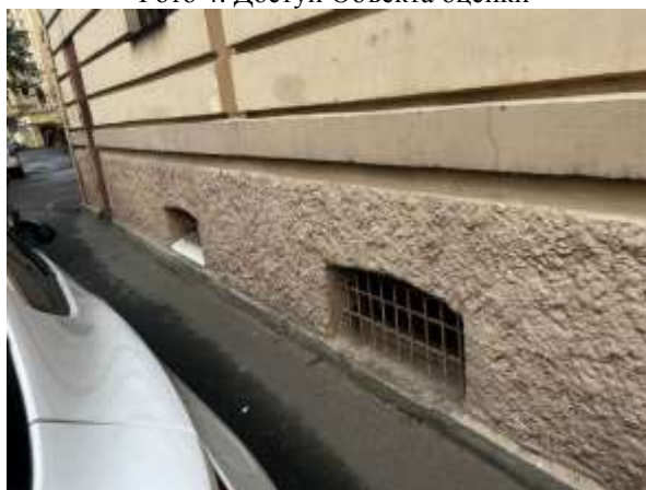
Фото 6. Вид окон Объекта оценки
