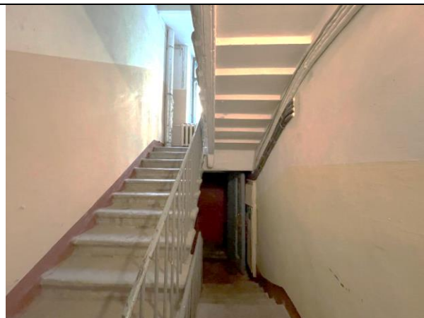
Фото 27. Лестничный проём Объекта оценки
