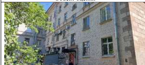
Фото 3. Вид здания, в котором расположен Объект оценки
