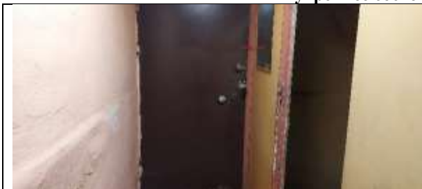
Фото 9. Внутреннее состояние Объекта оценки
