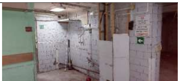
Фото 12. Внутреннее состояние Объекта оценки
