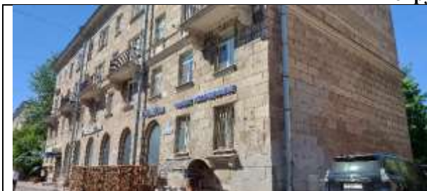
Фото 1. Вид здания, в котором расположен Объект оценки
