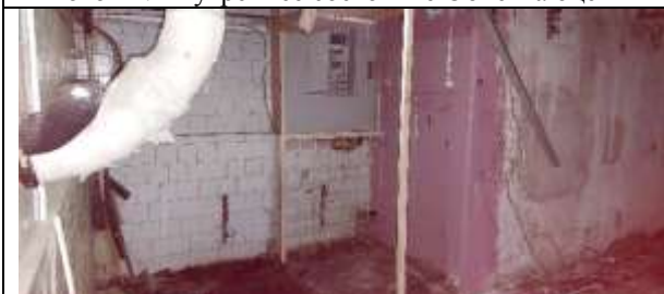
Фото 13. Внутреннее состояние Объекта оценки
