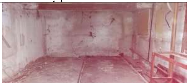
Фото 14. Внутреннее состояние Объекта оценки
