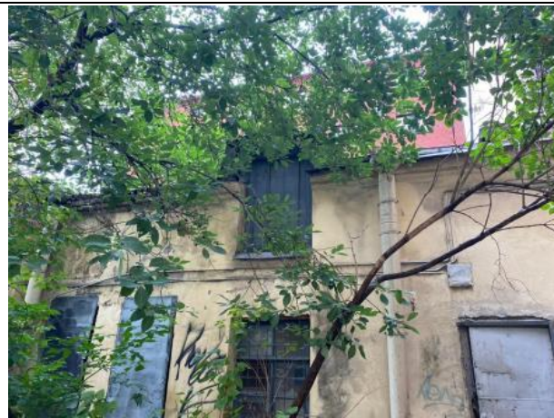
Фото № 12. Внешний вид здания
