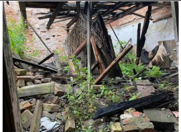
Фото № 6. Внешний вид здания
