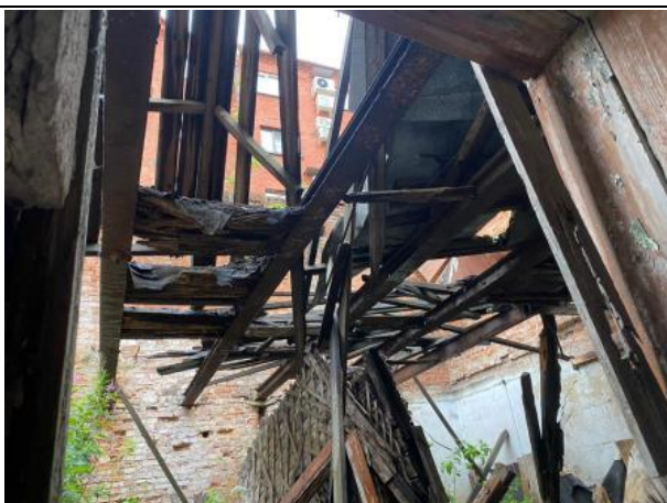
Фото № 7. Внешний вид здания
