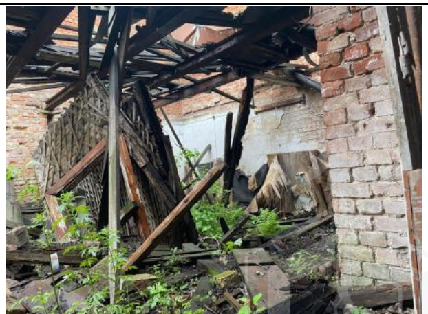
Фото № 8. Внешний вид здания
