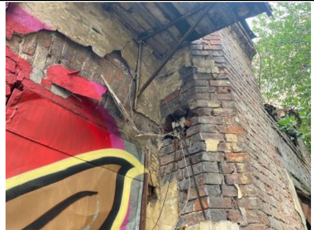
Фото № 4. Внешний вид здания
