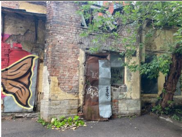
Фото № 3. Внешний вид здания
