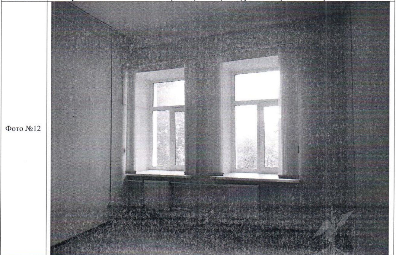
Описание: Вид на ч.п. 2 Объекта
