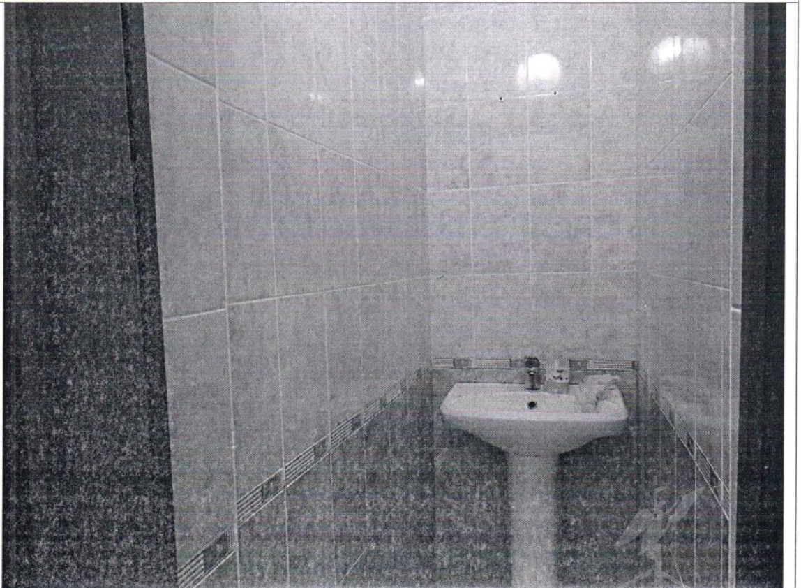
Описание: Вид на ч.п.7 Объекта
