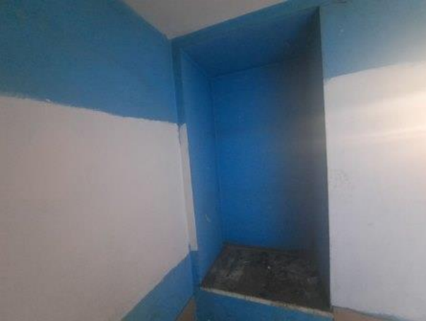
Фото № 15 – Внутреннее состояние помещения
