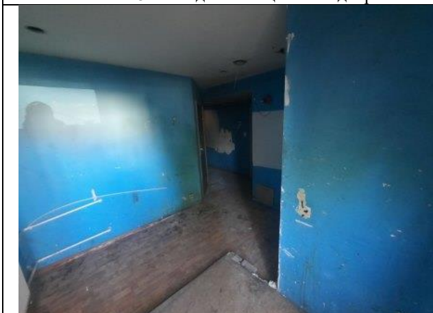
Фото № 7 – Внутреннее состояние помещения
