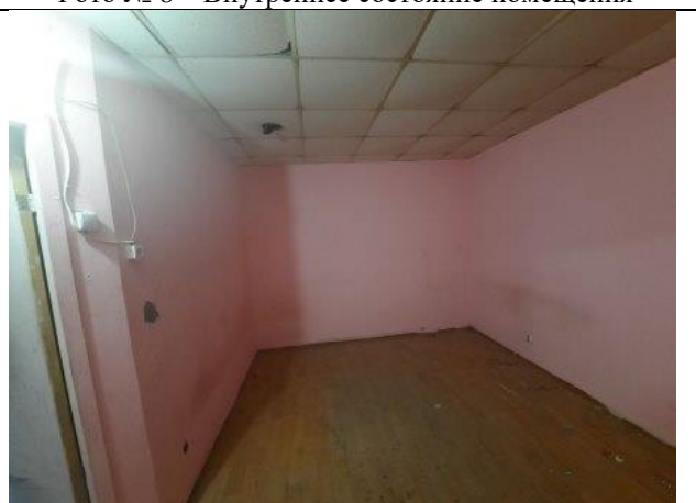
Фото № 10 – Внутреннее состояние помещения
