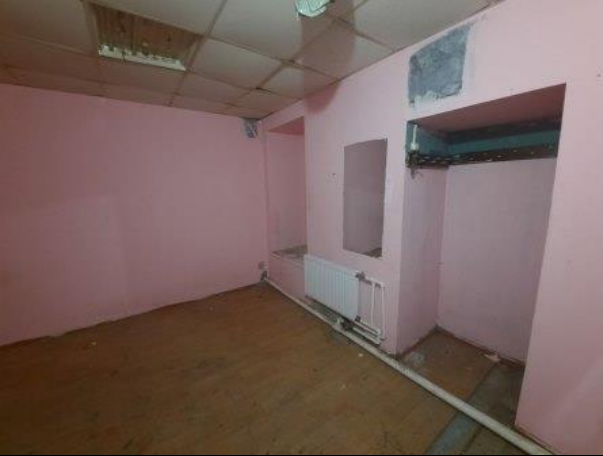
Фото № 13 – Внутреннее состояние помещения
