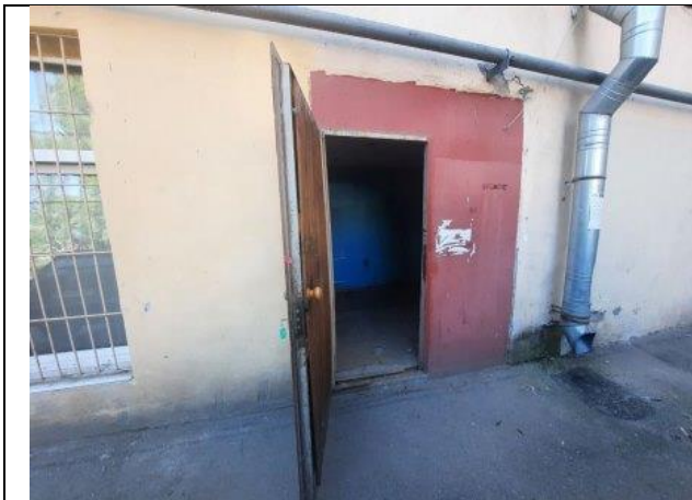
Фото № 5 – Вход в помещение со двора
