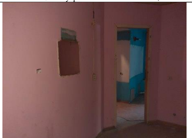
Фото № 8 – Внутреннее состояние помещения
