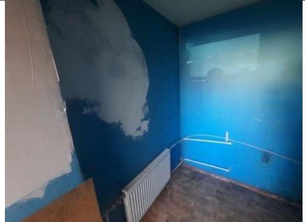
Фото № 16 – Внутреннее состояние помещения
