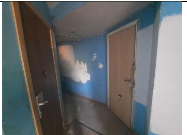
Фото № 6 – Внутреннее состояние помещения
