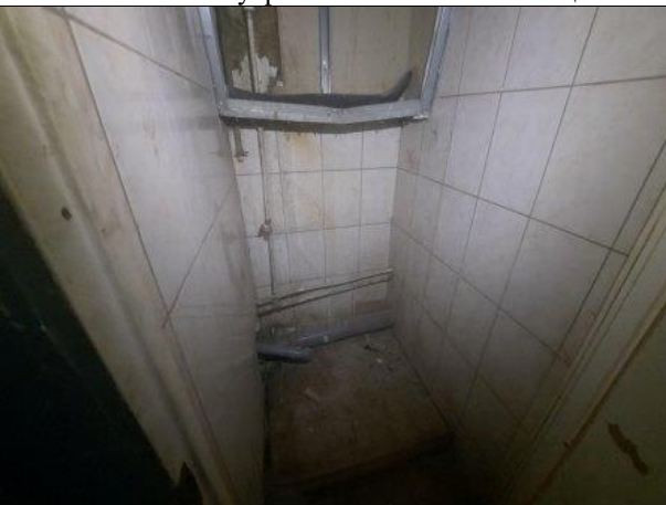
Фото № 19 – Внутреннее состояние помещения
