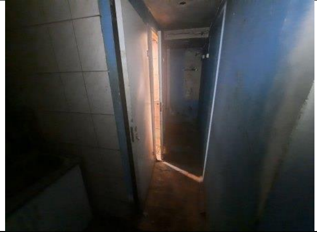
Фото № 14 – Внутреннее состояние помещения
