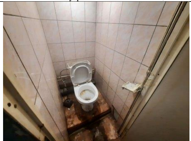
Фото № 18 – Внутреннее состояние помещения
