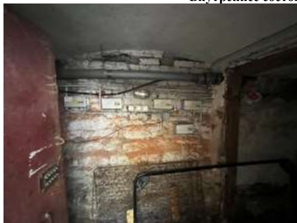
Фото 7. Вход в помещение
