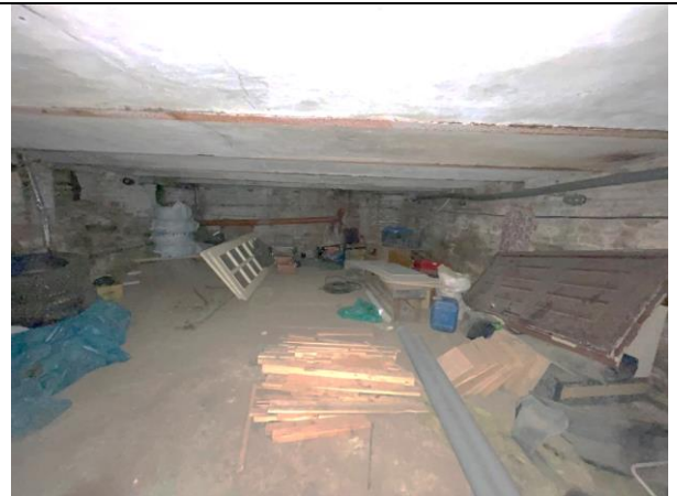
Фото 28. Типичное состояние Объекта оценки
