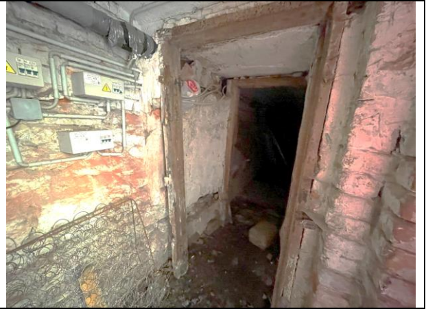
Фото 20. Типичное состояние объекта оценки
