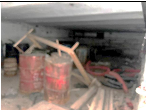
Фото 23. Типичное состояние объекта оценки
