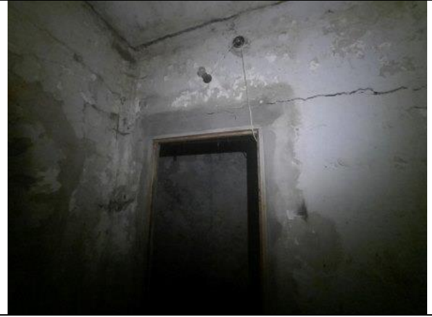
Фото № 22 – Внутреннее состояние помещения
