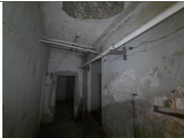
Фото № 8 – Внутреннее состояние помещения
