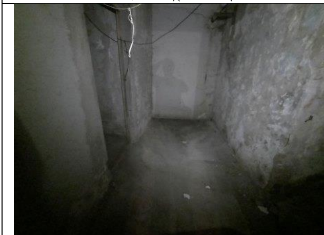
Фото № 9 – Внутреннее состояние помещения
