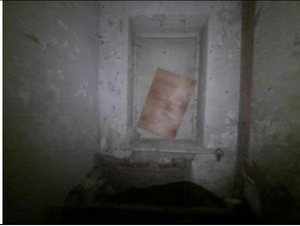
Фото № 21 – Внутреннее состояние помещения
