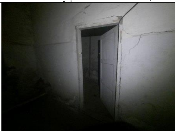
Фото № 19 – Внутреннее состояние помещения
