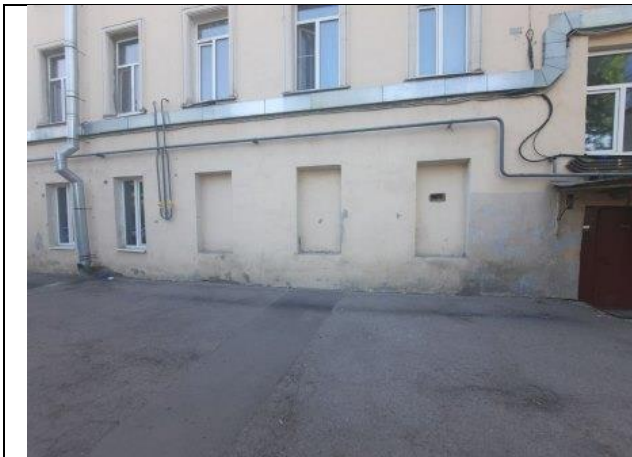
Фото № 5 – Окна помещения
