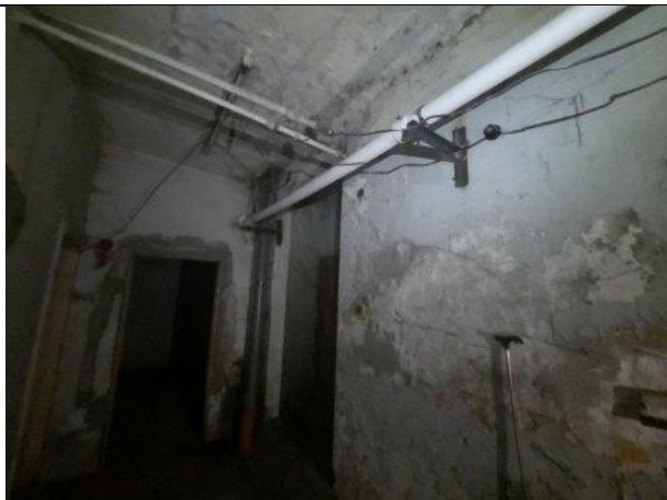
Фото № 13 – Внутреннее состояние помещения
