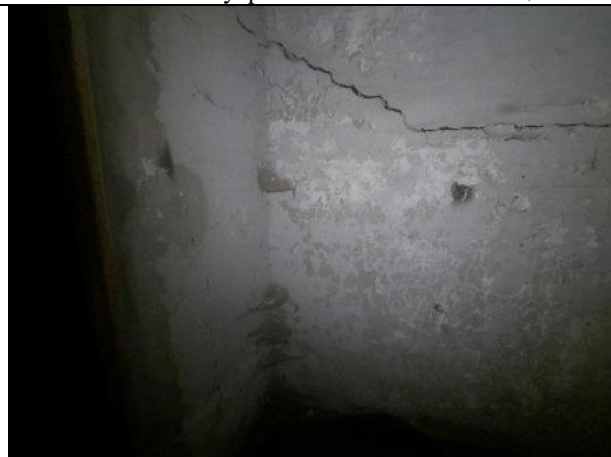
Фото № 16 – Внутреннее состояние помещения
