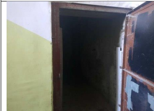
Фото № 7 – Вход в помещение
