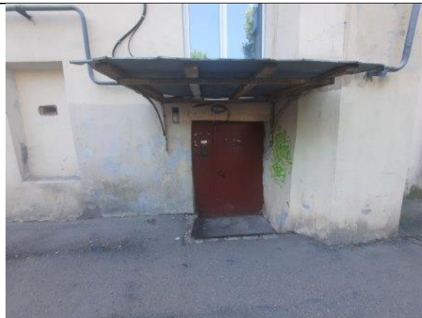
Фото № 6 – Общий вход
