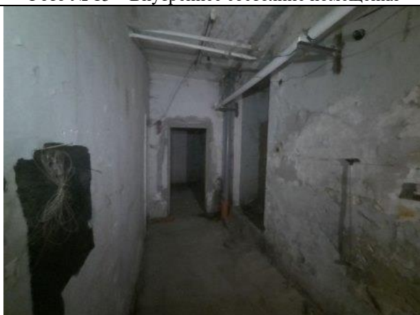
Фото № 17 – Внутреннее состояние помещения
