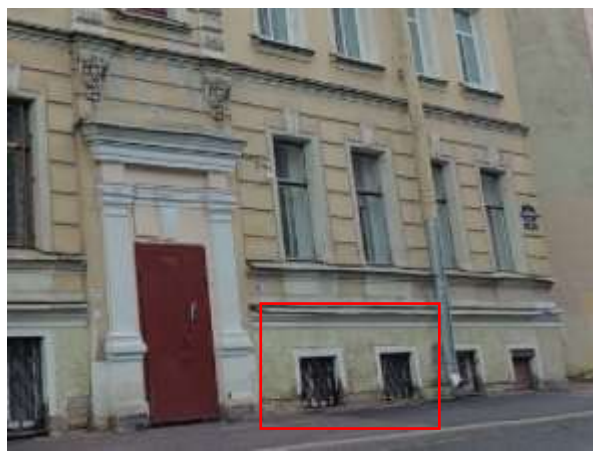
Фото 8. Вид окон Объекта оценки
