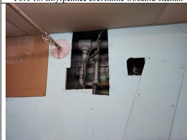
Фото 15. Внутреннее состояние Объекта оценки
