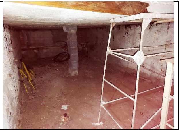
Фото 20. Внутреннее состояние Объекта оценки
