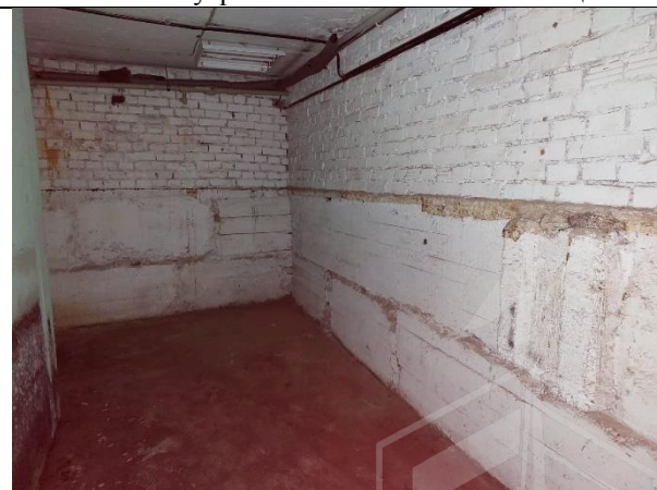
Фото 18. Внутреннее состояние Объекта оценки
