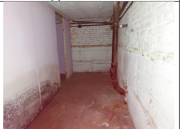
Фото 22. Внутреннее состояние Объекта оценки
