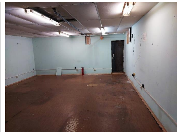
Фото 11. Внутреннее состояние Объекта оценки
