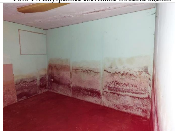
Фото 16. Внутреннее состояние Объекта оценки
