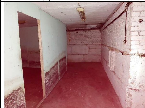
Фото 17. Внутреннее состояние Объекта оценки
