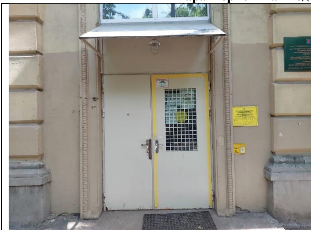
Фото 3. Общий вход 1 Объекта оценки со двора
