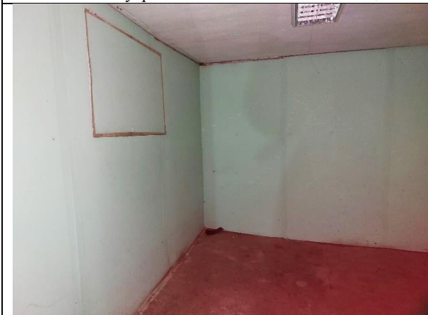
Фото 21. Внутреннее состояние Объекта оценки
