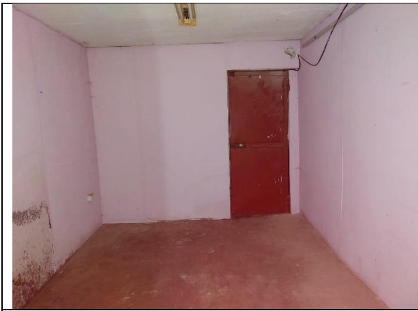
Фото 19. Внутреннее состояние Объекта оценки
