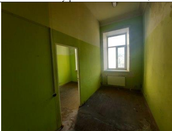
Фото №19– Внутреннее состояние помещения
