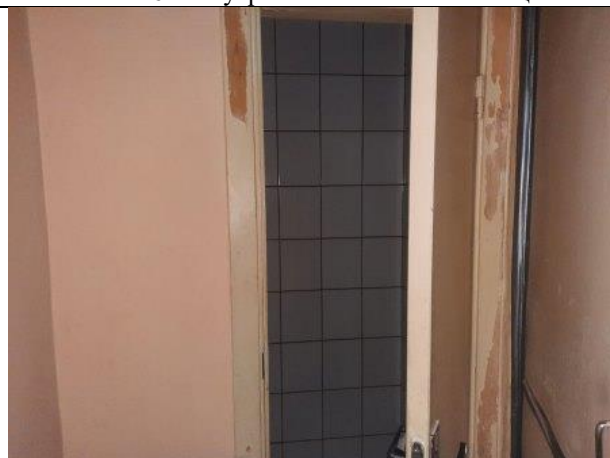
Фото № 28 – Внутреннее состояние помещения
