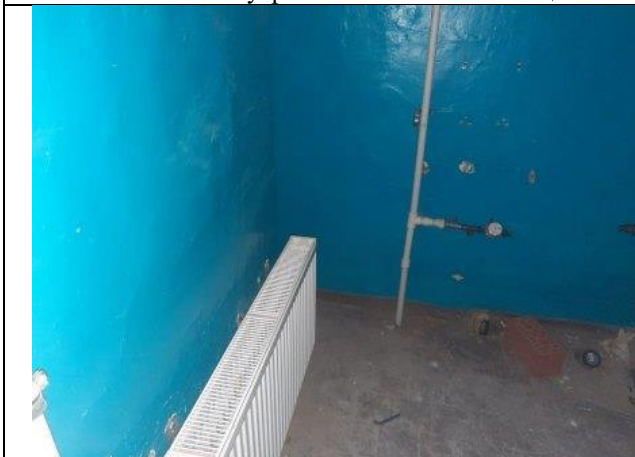
Фото № 25 – Внутреннее состояние помещения
