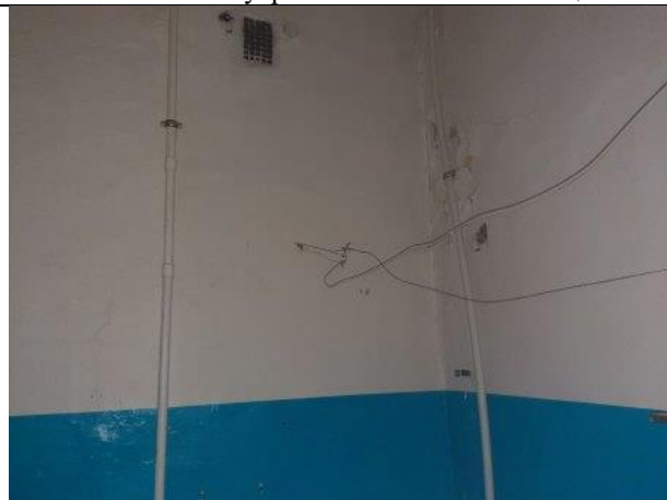
Фото № 26 – Внутреннее состояние помещения
