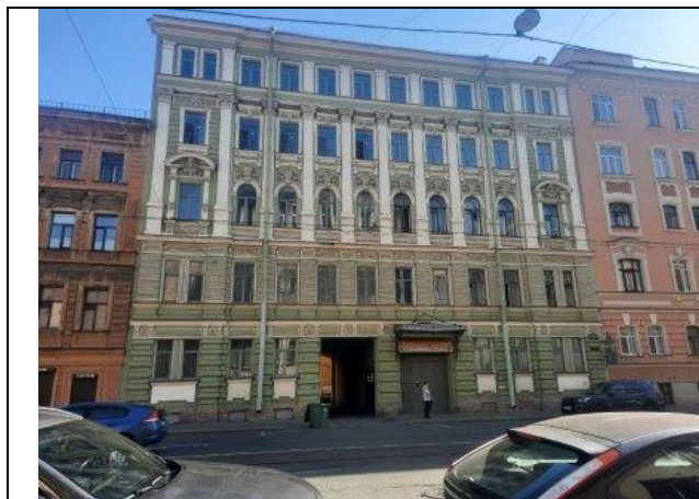
Фото № 1 – Здание, в котором находится Объект оценки
