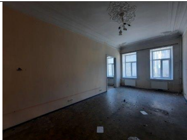
Фото № 24 – Внутреннее состояние помещения
