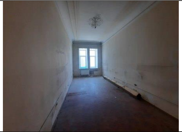
Фото № 16 – Внутреннее состояние помещения
