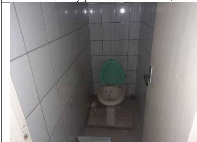
Фото № 27 – Внутреннее состояние помещения
