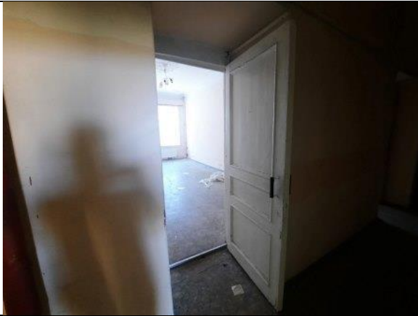
Фото № 15 – Внутреннее состояние помещения
