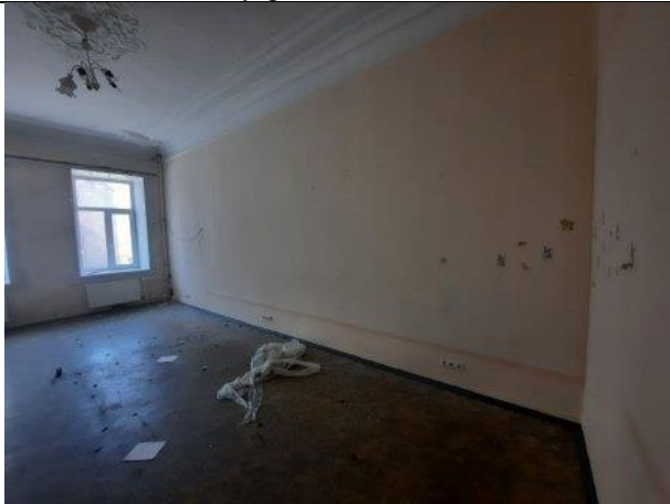
Фото № 17 – Внутреннее состояние помещения
