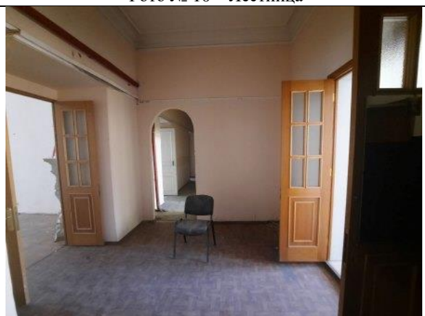
Фото № 12 – Внутреннее состояние помещения
