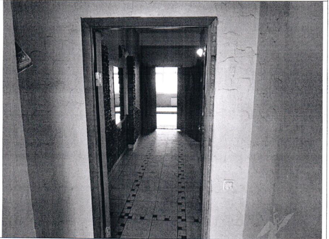
Описание: между ч.п. 8 и 9 Объекта оборудован дверной проем
