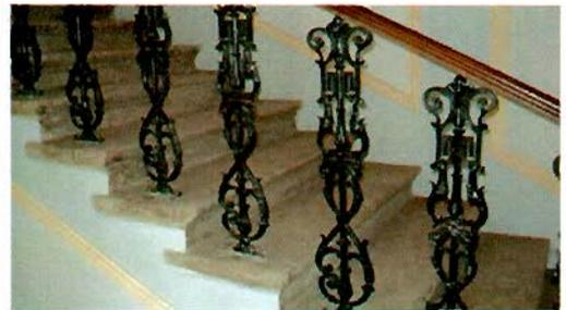
лестница № 1 – местоположение, габариты, конфигурация, тип (многомаршевая), конструкция (на косоурах), материал ступеней (известняк), ограждение – материал (металл), техника исполнения (литье), рисунок, материал покрытия пола площадок (известняк);
