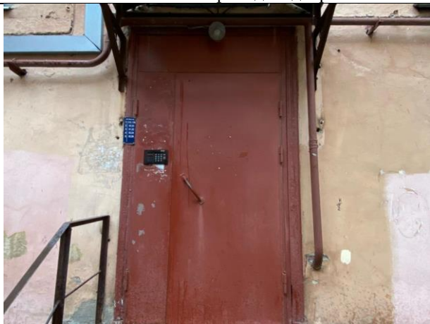
Фото № 5 – Общий вход в помещение со двора
