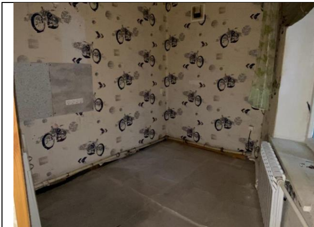
Фото № 15 – Внутреннее состояние помещения
