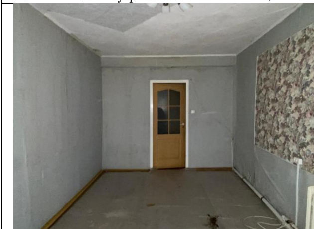
Фото № 11 – Внутреннее состояние помещения
