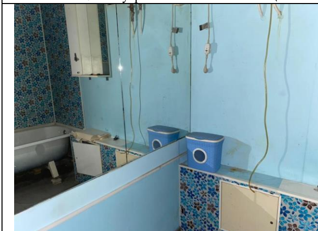
Фото № 19 – Внутреннее состояние помещения
