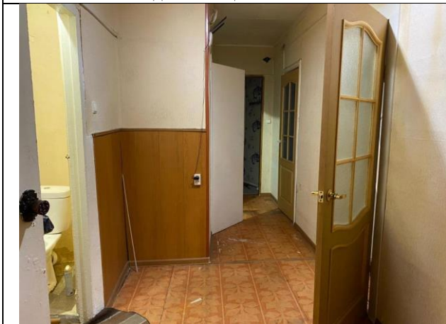
Фото № 9 – Внутреннее состояние помещения
