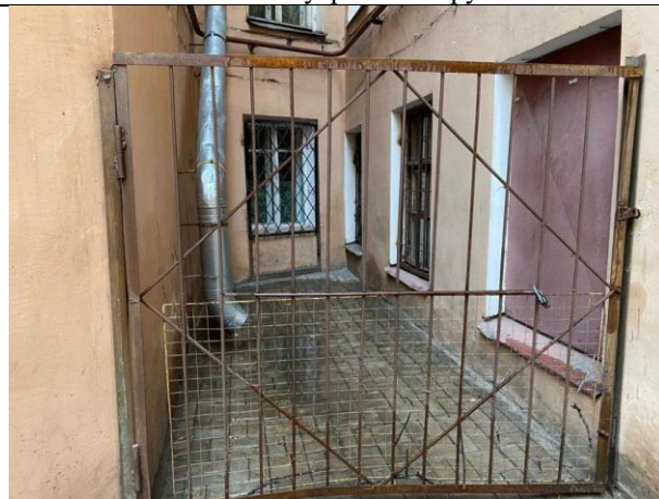
Фото № 6 – Отдельный вход в помещение со двора (переоборудованный оконный проем)
