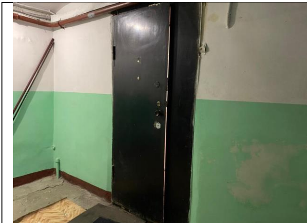
Фото № 7 – Вход в помещение с лестничной клетки
