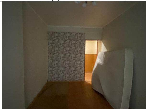
Фото № 10 – Внутреннее состояние помещения
