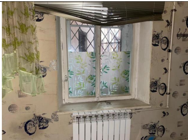
Фото № 16 – Внутреннее состояние помещения
