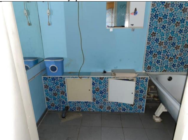
Фото № 18 – Внутреннее состояние помещения
