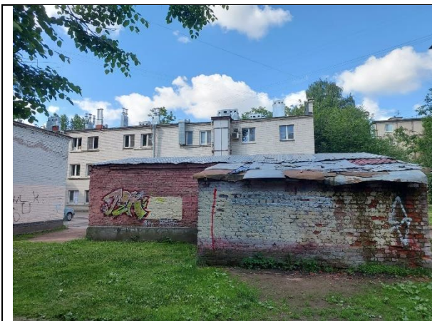
Фото 3. Вид здания, в котором расположен Объект оценки
