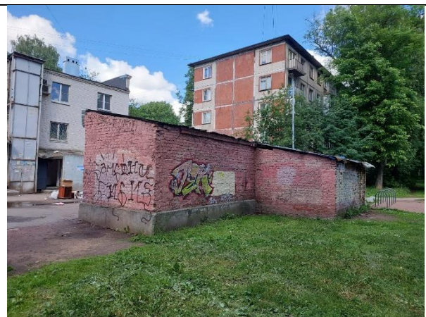
Фото 4. Вид здания, в котором расположен Объект оценки
