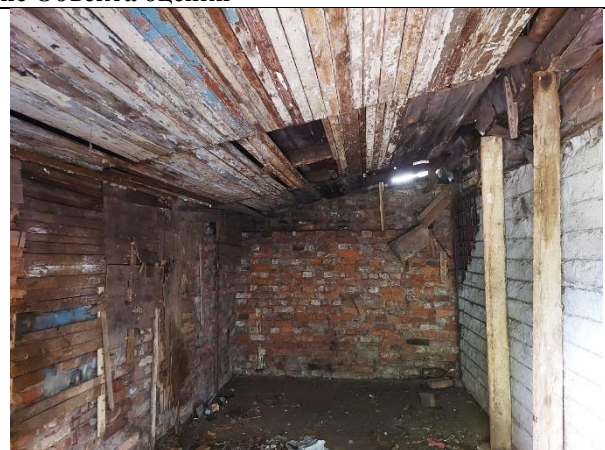
Фото 8. Внутреннее состояние Объекта оценки
