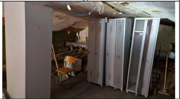
Фото 16. Типичное состояние Объекта оценки
