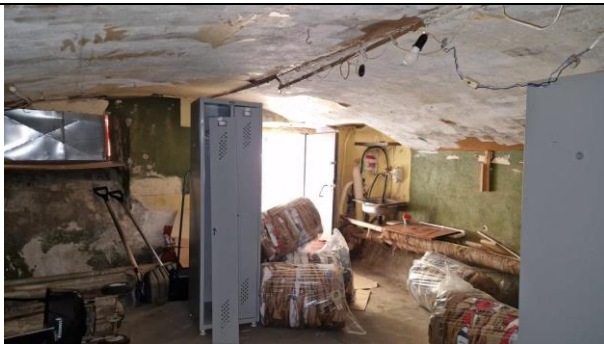
Фото 19. Типичное состояние Объекта оценки
