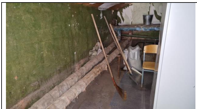
Фото 21. Типичное состояние Объекта оценки
