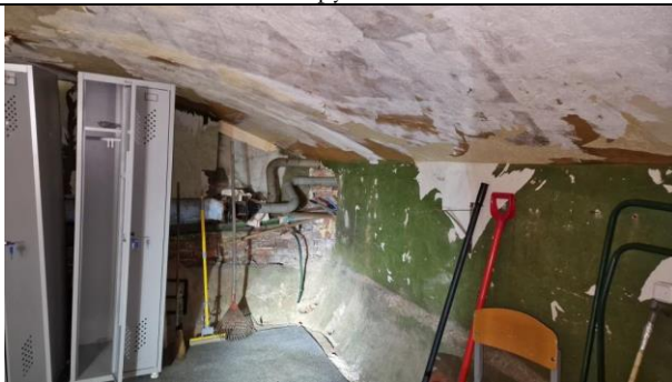
Фото 17. Типичное состояние Объекта оценки
