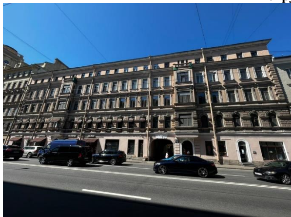
Фото 1. Вид здания, в котором расположен Объект оценки
