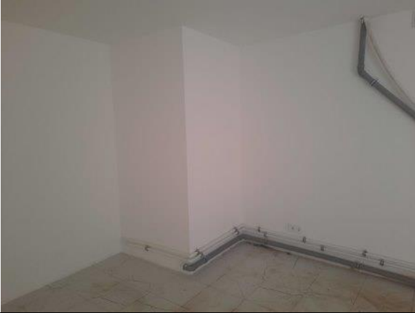
Фото № 15 – Внутреннее состояние помещения
