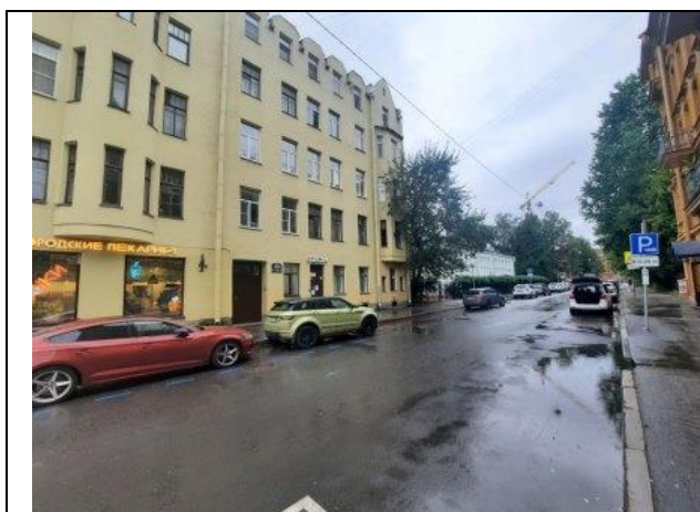
Фото № 1 – Подъездные пути
