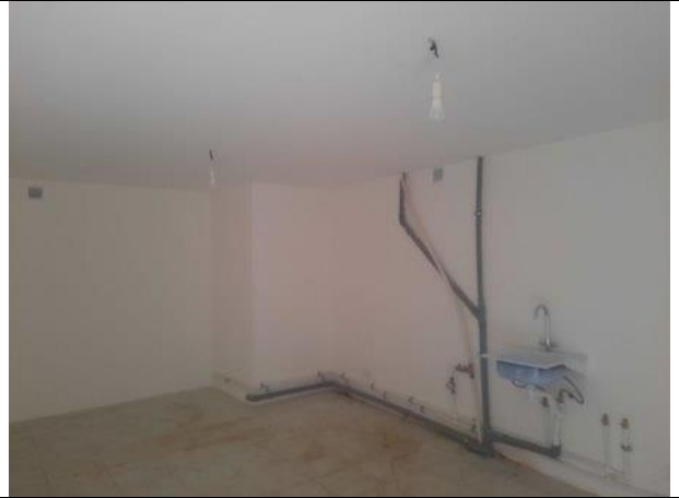
Фото № 14 – Внутреннее состояние помещения
