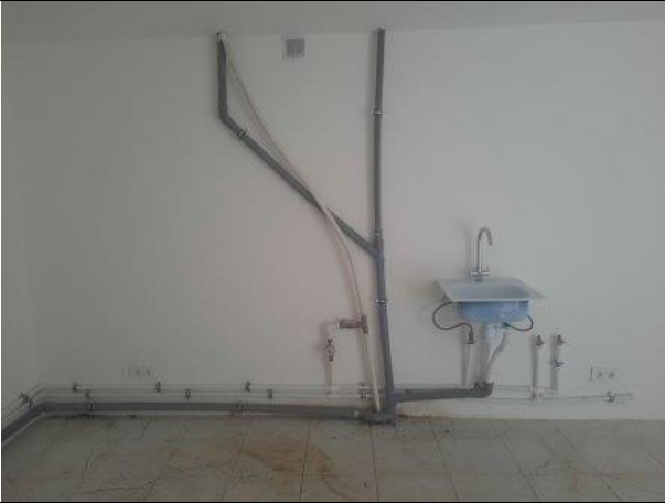
Фото № 13 – Внутреннее состояние помещения
