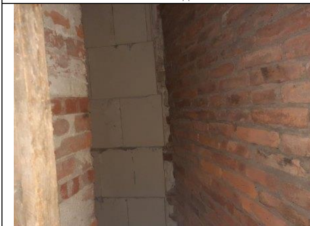
Фото № 9 – Внутреннее состояние помещения
