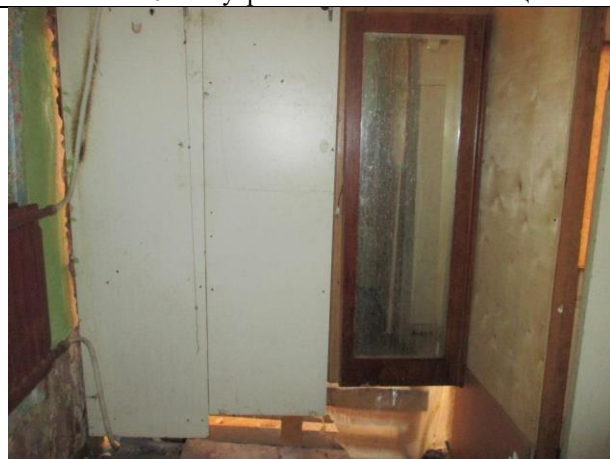
Фото № 18 – Внутреннее состояние помещения
