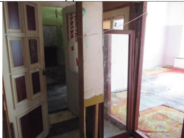
Фото № 10 – Внутреннее состояние помещения
