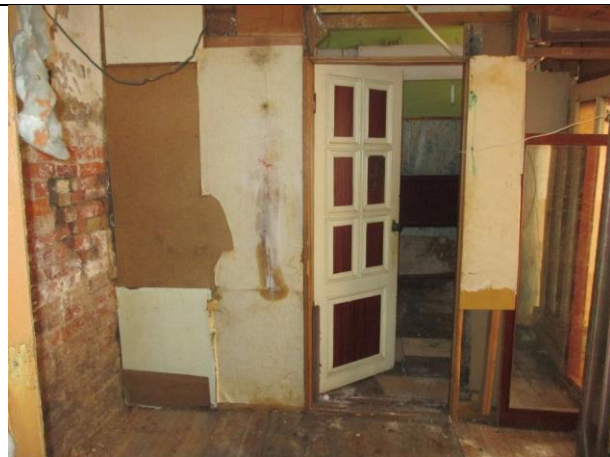
Фото № 8 – Внутреннее состояние помещения
