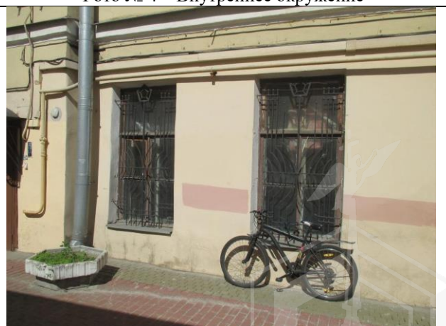
Фото № 6 – Окна помещения
