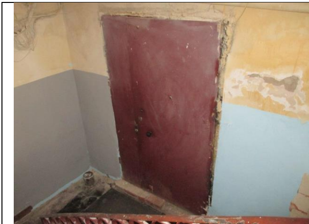
Фото № 7 – Вход в помещение
