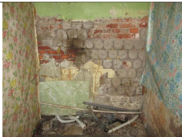
Фото № 16 – Внутреннее состояние помещения
