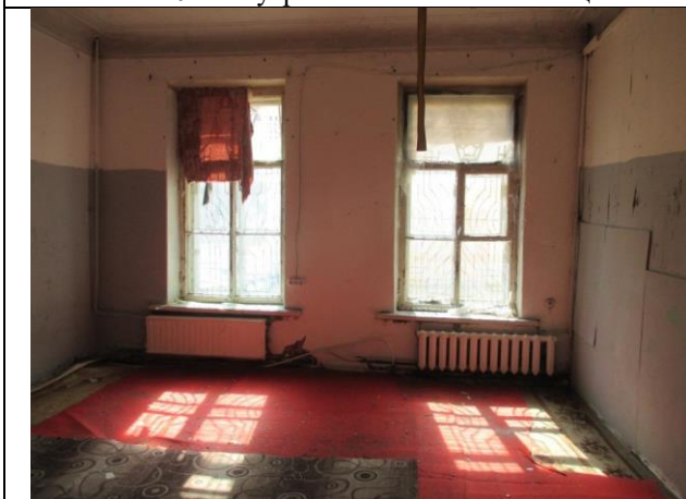
Фото № 11 – Внутреннее состояние помещения
