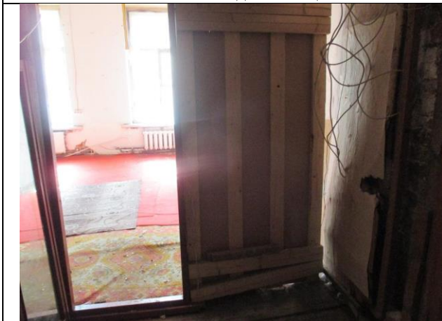
Фото № 9 – Внутреннее состояние помещения
