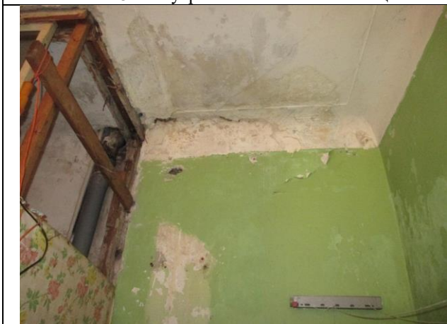
Фото № 17 – Внутреннее состояние помещения
