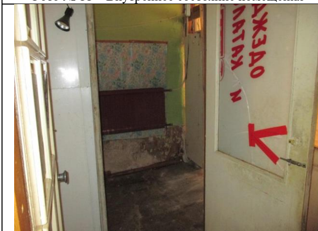
Фото № 13 – Внутреннее состояние помещения
