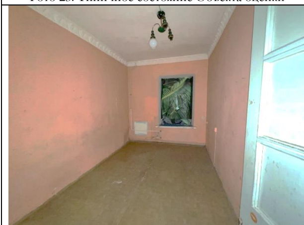
Фото 25. Типичное состояние Объекта оценки
