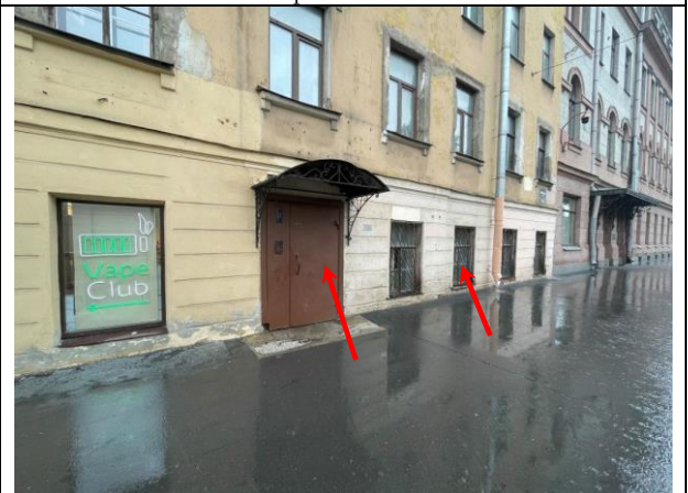
Фото 18. Входная и оконная группа Объекта оценки
