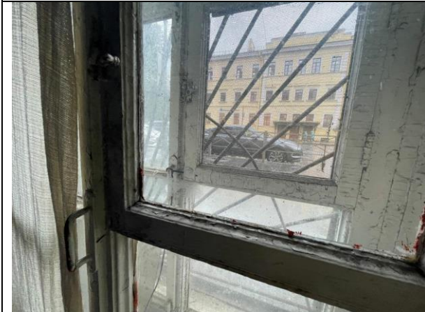
Фото 31. Оконная группа Объекта оценки (вид на улицу)
