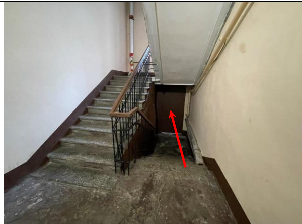
Фото 47. Входная группа Объекта оценки, выход во двор, лестничный проём Объекта оценки
