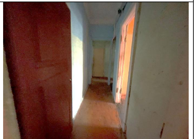
Фото 34. Типичное состояние Объекта оценки
