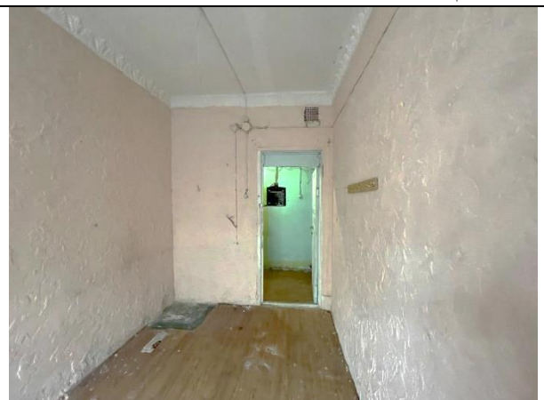
Фото 26. Типичное состояние Объекта оценки
