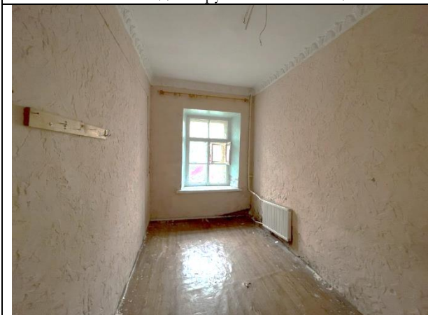
Фото 23. Типичное состояние Объекта оценки
