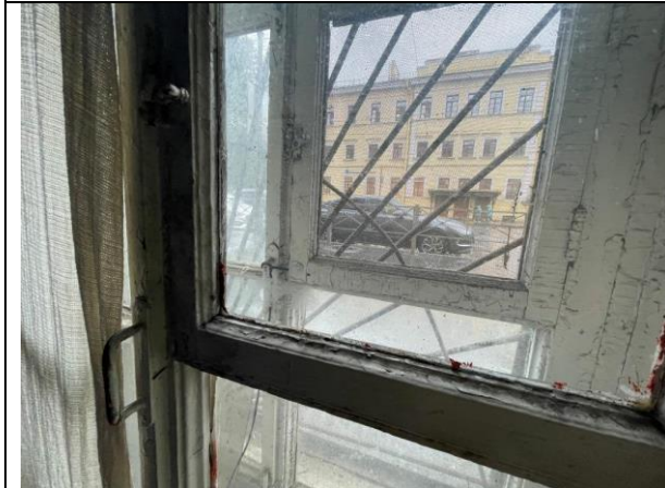
Фото 31. Оконная группа Объекта оценки (вид на улицу)
