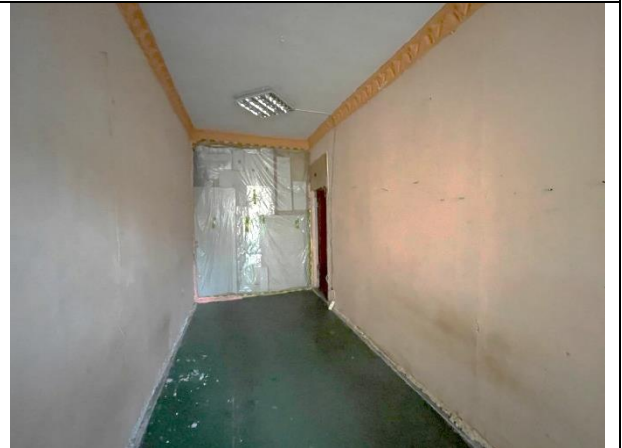
Фото 32. Типичное состояние Объекта оценки
