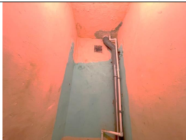
Фото 43. Типичное состояние Объекта оценки
