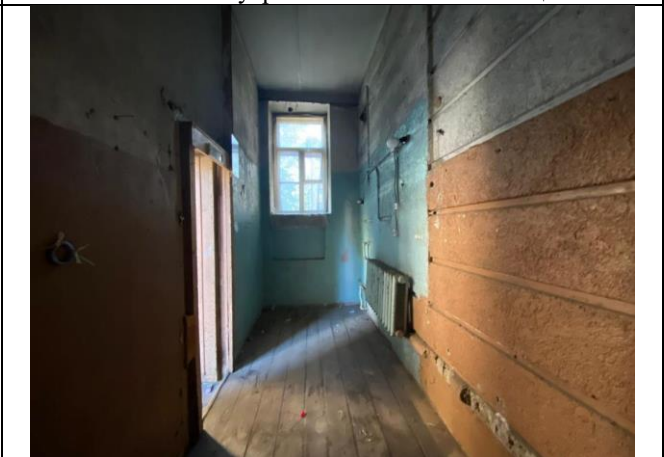
Фото № 10 – Внутреннее состояние помещения
