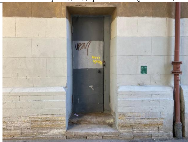
Фото № 6 – Вход в помещение
