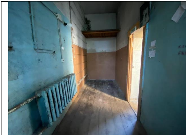
Фото № 7 – Внутреннее состояние помещения
