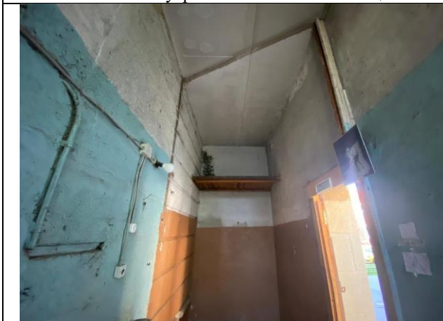
Фото № 9 – Внутреннее состояние помещения
