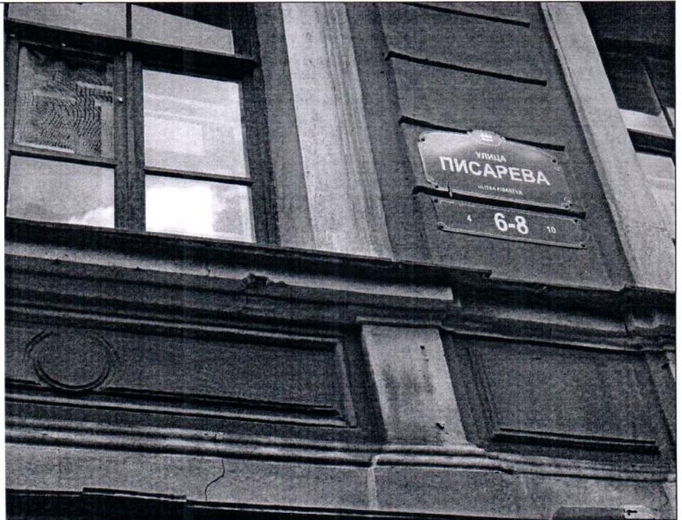
Описание: Фасад здания с адресной табличкой
