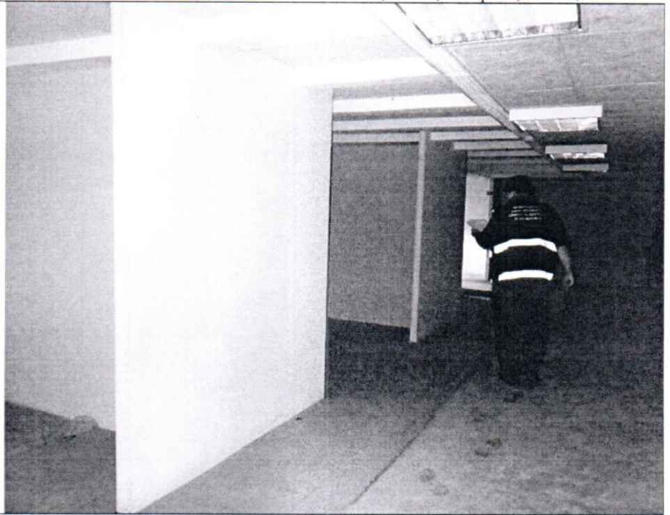
Описание: Вид внутри Объекта
