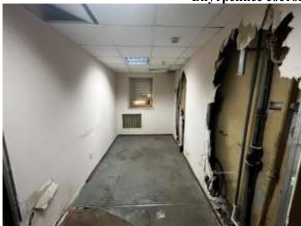
Фото 7. Вход в помещение
