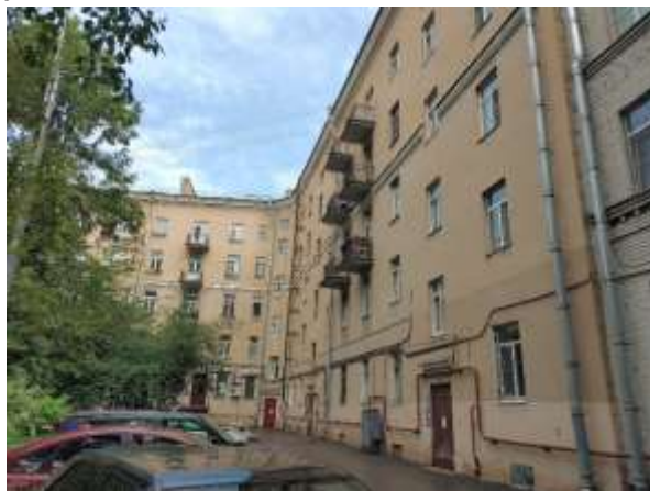
Фото 2. Вид здания, в котором расположен Объект оценки
