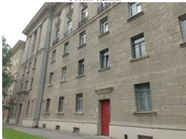
Фото 3. Вид здания, в котором расположен Объект оценки
