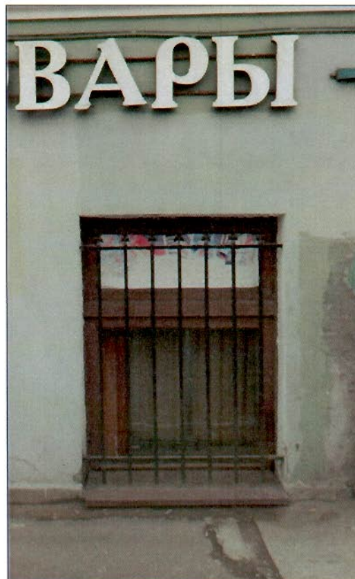
12. "Дом Кукановой А. (Кладо Л.М.)". Лицевой фасад со стороны наб. р. Фонтанки. Оконный проем.
