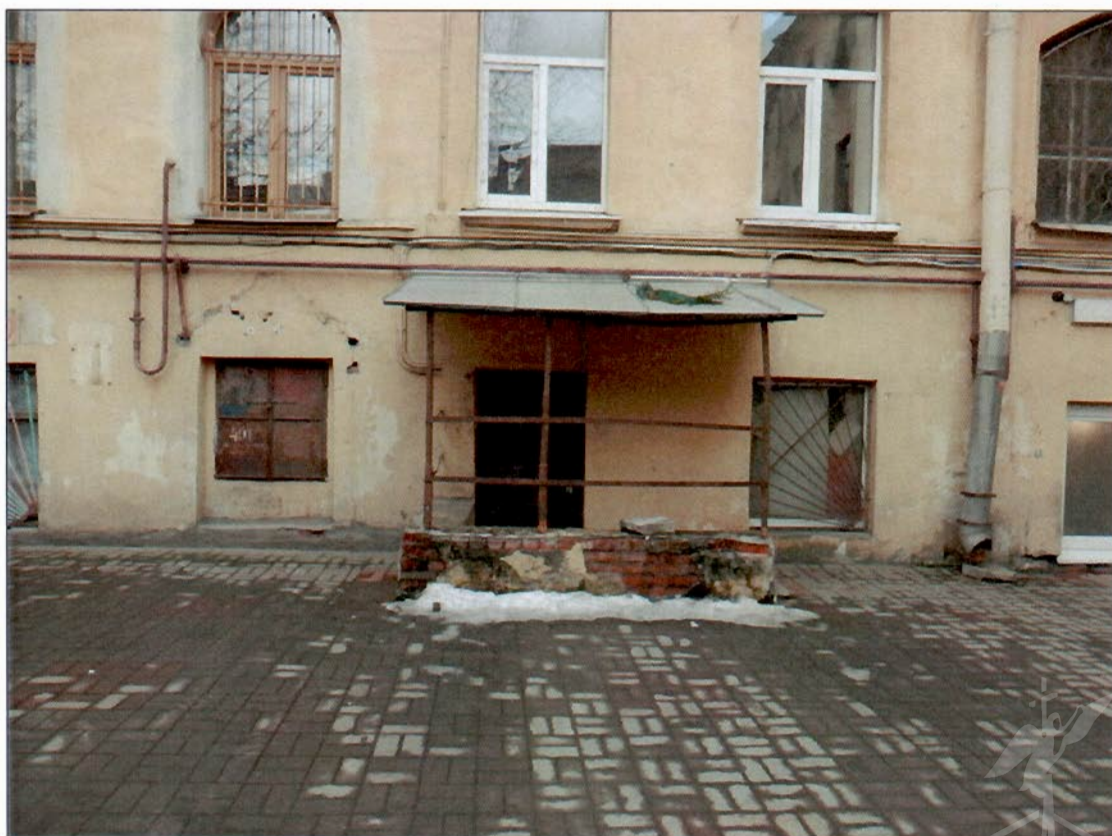
14. "Дом Кукановой А. (Кладо Л.М.)". Дворовый фасад лицевого корпуса по наб. р. Фонтанки. Прямок.
