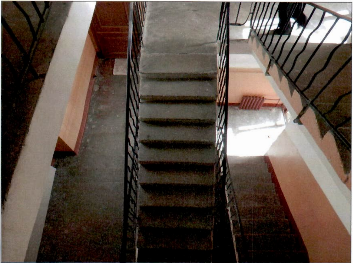
22. Двухмаршевая лестница (лицевой корпус по Гороховой улице).
