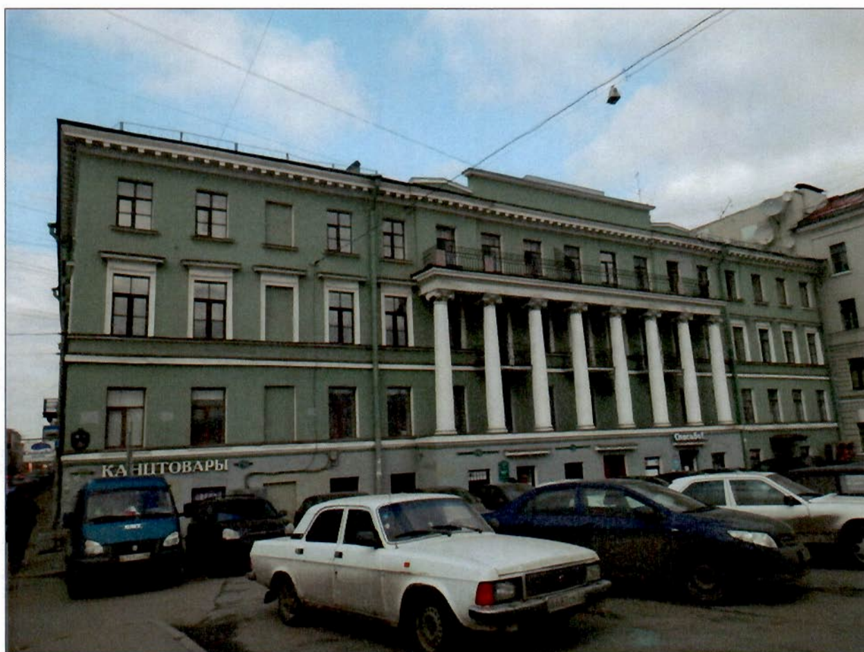
2. "Дом Кукановой А. (Кладо Л.М.)". Лицевой фасад со стороны набережной реки Фонтанки.
