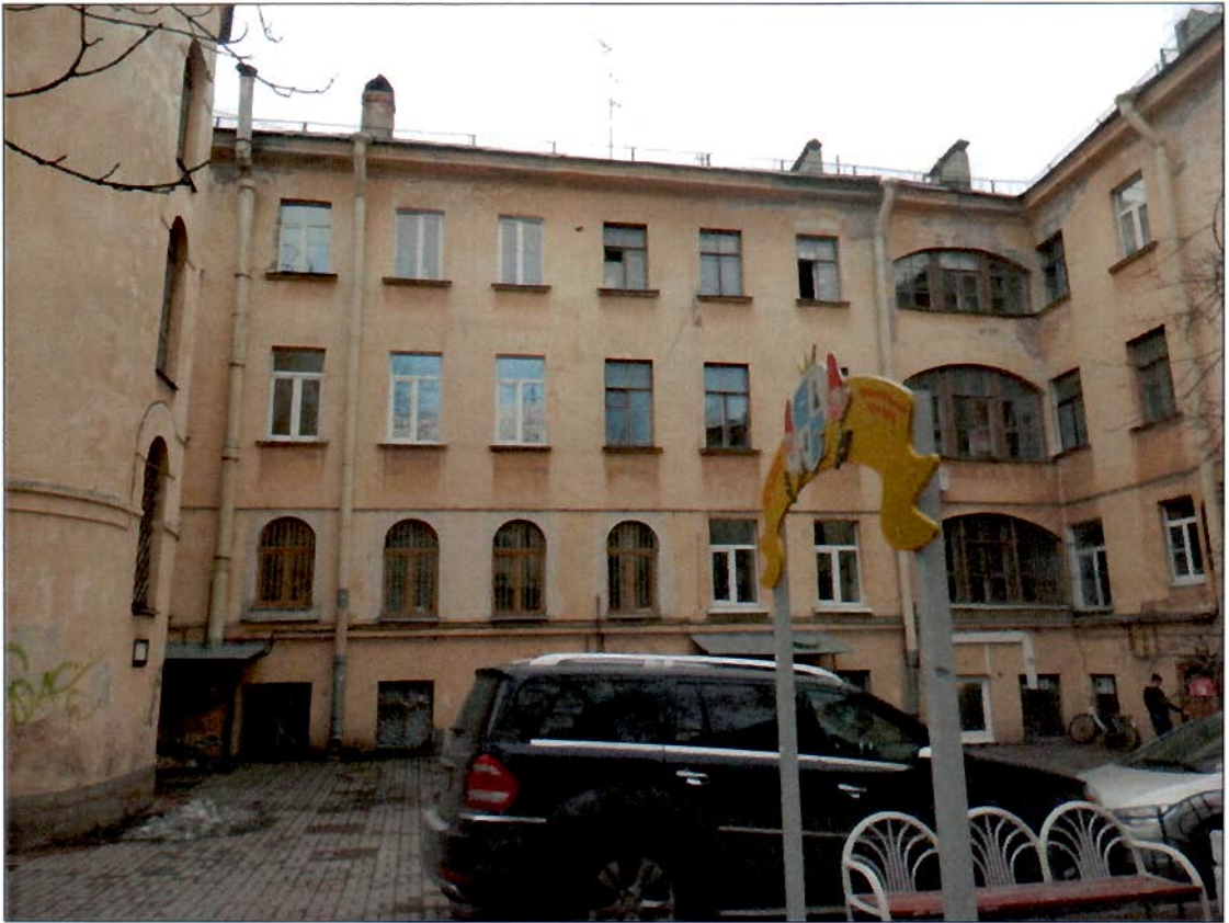
5. "Дом Кукановой А. (Кладо Л.М.)". Южный дворовый фасад. Фрагмент.
