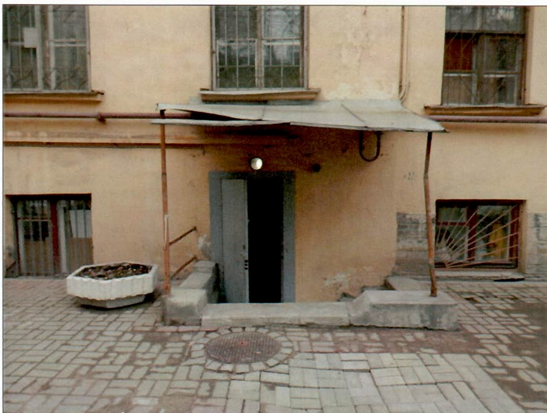
15. "Дом Кукановой А. (Кладо Л.М.)". Северный дворовый корпус. Прямок.
