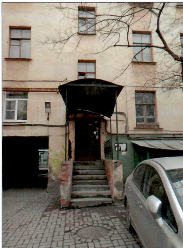
13. "Дом Кукановой А. (Кладо Л.М.)". Западный дворовый фасад. Фрагмент. Крыльцо.
