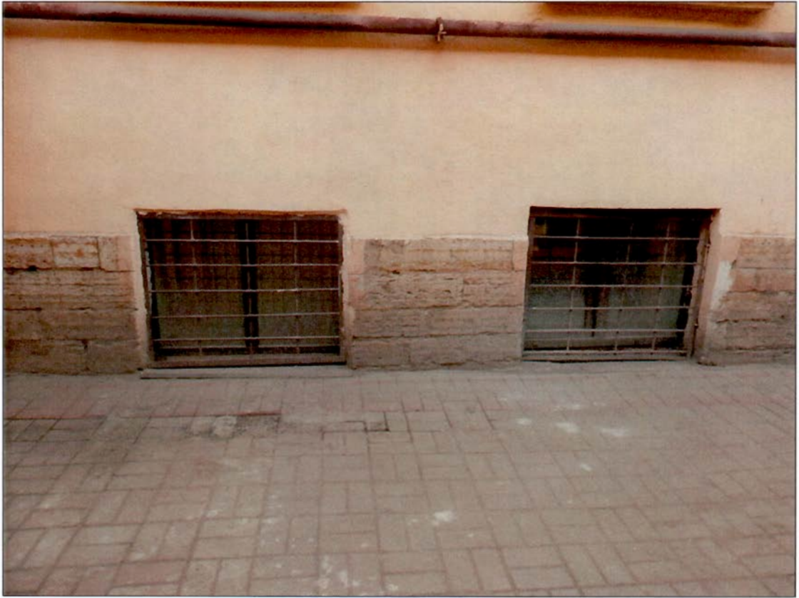
17. "Дом Кукановой А. (Кладо Л.М.)". Дворовый фасад. Оконные проемы.
