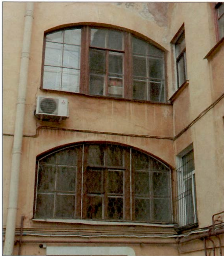
18. "Дом Кукановой А. (Кладо Л.М.)". Дворовый фасад. Оконные проемы.
