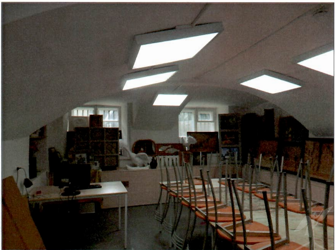
29. Северный дворовый корпус. Помещение в уровне цокольного этажа.
