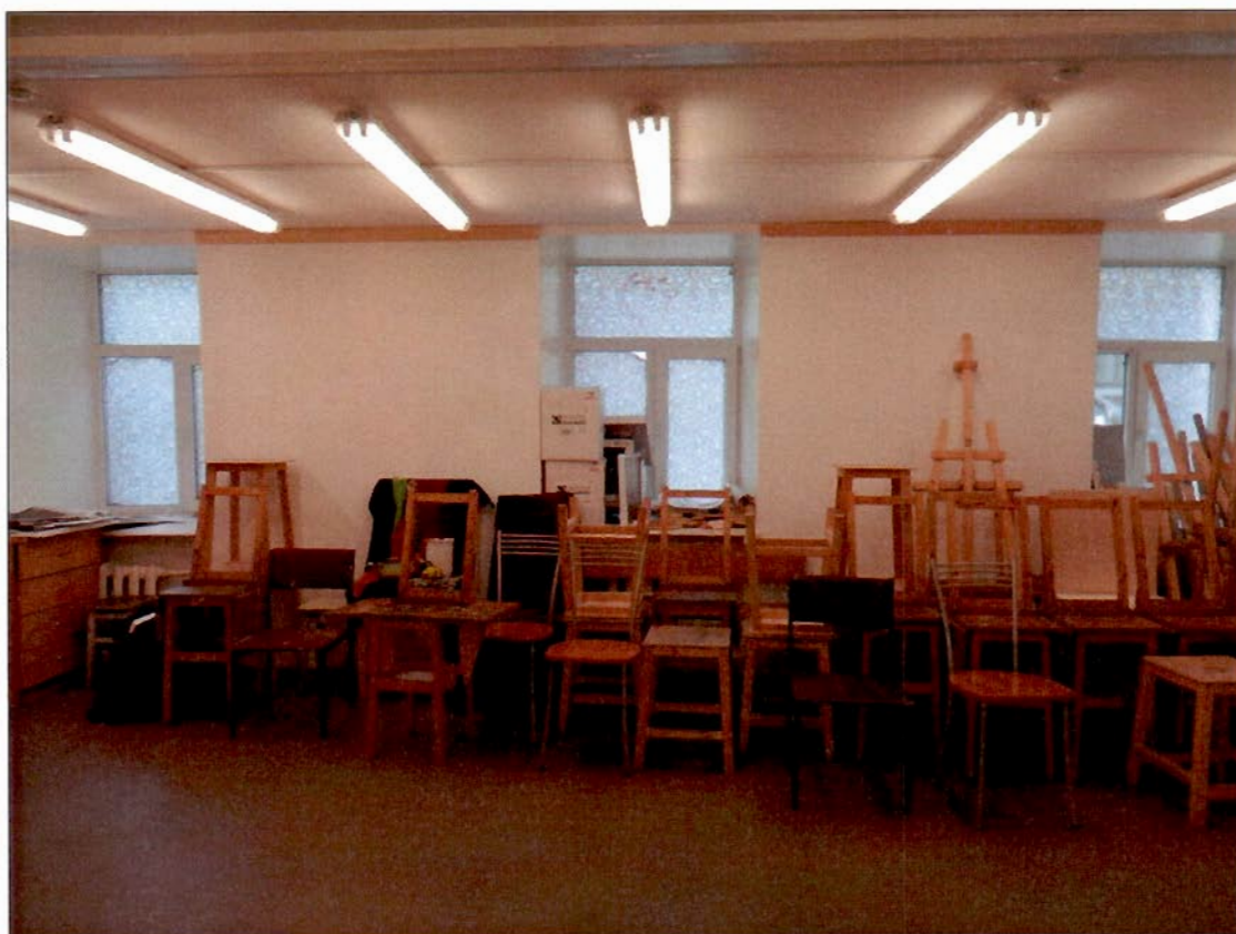
30. Лицевой корпус по Гороховой ул. Помещение в уровне цокольного этажа.
