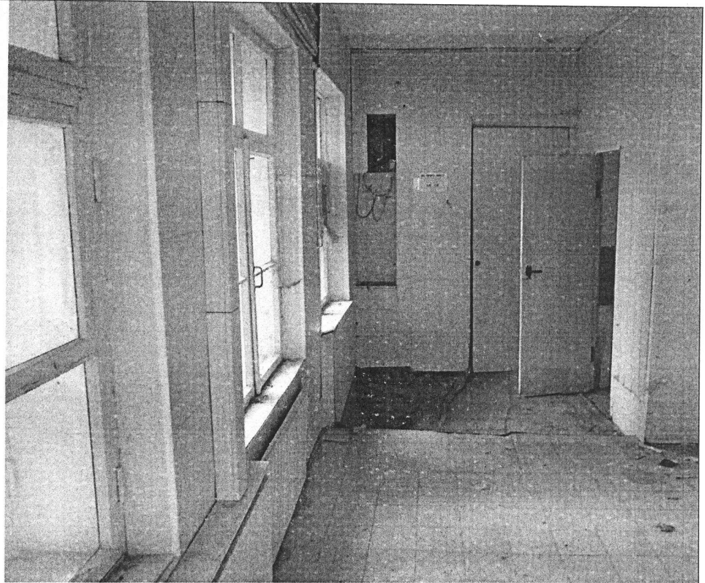
Описание: Общий вид внутри Объекта
