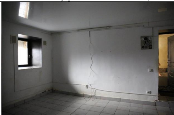
Фото № 11 – Внутреннее состояние помещения
