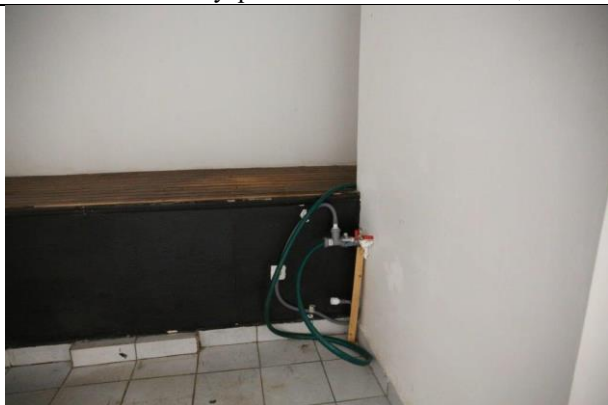
Фото № 9 – Внутреннее состояние помещения
