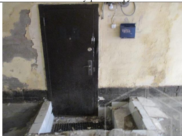
Фото № 6 – Вход в помещение со двора
