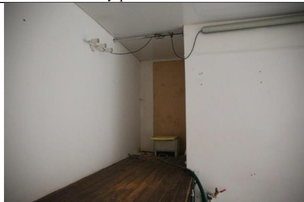
Фото № 10 – Внутреннее состояние помещения
