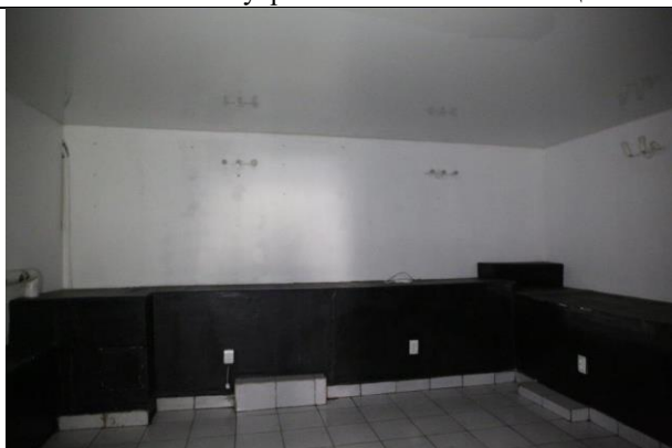
Фото № 13 – Внутреннее состояние помещения
