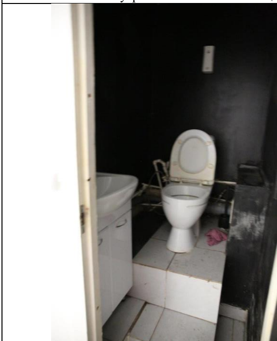
Фото № 17 – Внутреннее состояние помещения
