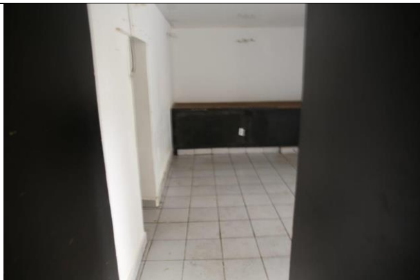
Фото № 7 – Внутреннее состояние помещения
