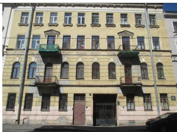
Фото № 2 – Здание, в котором находится Объект оценки
