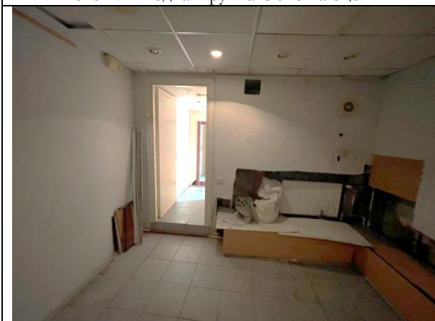
Фото 19. Типичное состояние Объекта оценки
