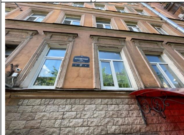
Фото 9. Адрес Объекта оценки
