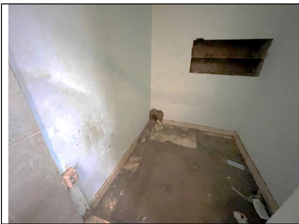
Фото 33. Типичное состояние Объекта оценки
