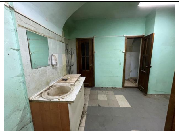
Фото 26. Типичное состояние Объекта оценки
