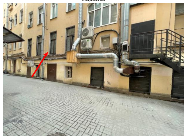
Фото 22. Вид здания расположения Объекта оценки
