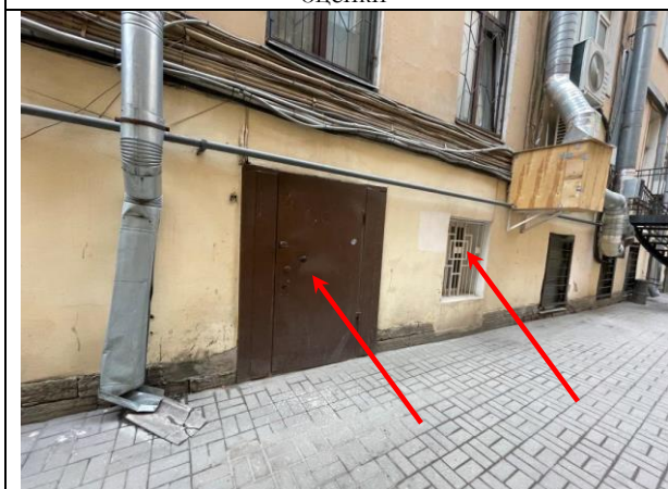
Фото 23. Входная и оконная группа Объекта оценки
