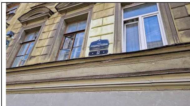
Фото 5. Адрес Объекта оценки
