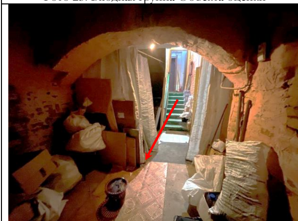
Фото 25. Типичное состояние Объекта оценки
