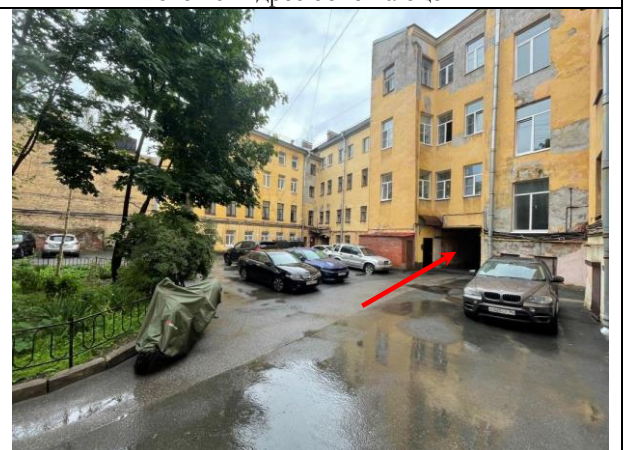
Фото 18. Проход через арку к Объекту оценки
