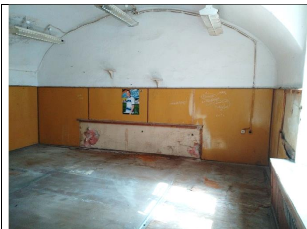
Фото 19. Внутреннее состояние Объекта оценки
