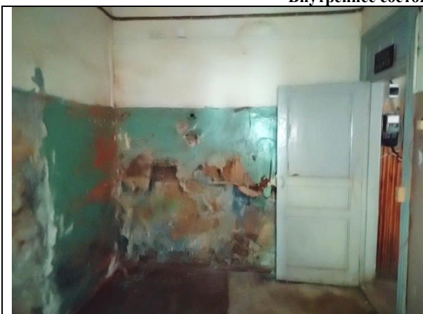
Фото 15. Внутреннее состояние Объекта оценки
