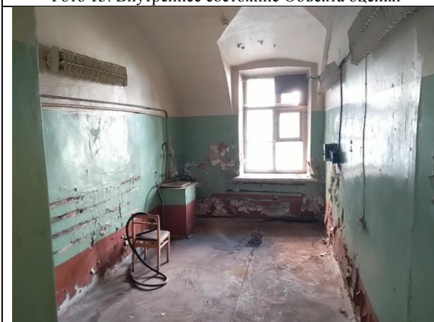
Фото 17. Внутреннее состояние Объекта оценки
