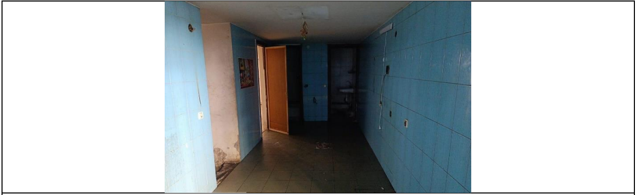
Фото 10. Внутреннее состояние Объекта оценки
