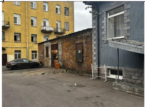
Фото 2. Вид здания, в котором расположен Объект оценки
