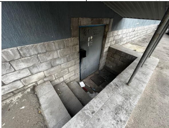
Фото 7. Вход Объекта оценки
