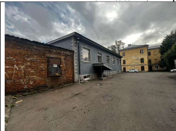
Фото 1. Вид здания, в котором расположен Объект оценки
