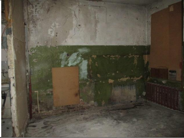
Фото № 9 – Внутреннее состояние помещения
