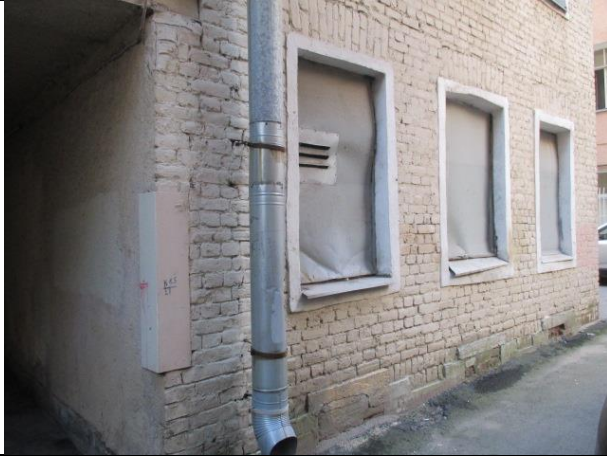
Фото № 7 – Окна помещения
