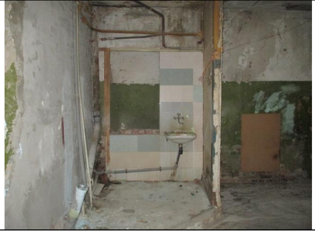
Фото № 8 – Внутреннее состояние помещения
