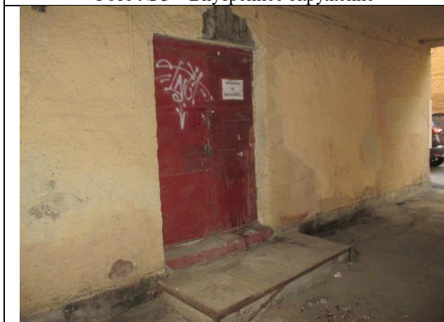
Фото № 5 – Вход в помещение из-под арки
