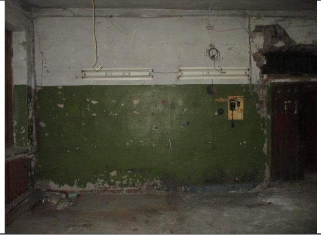
Фото № 10 – Внутреннее состояние помещения
