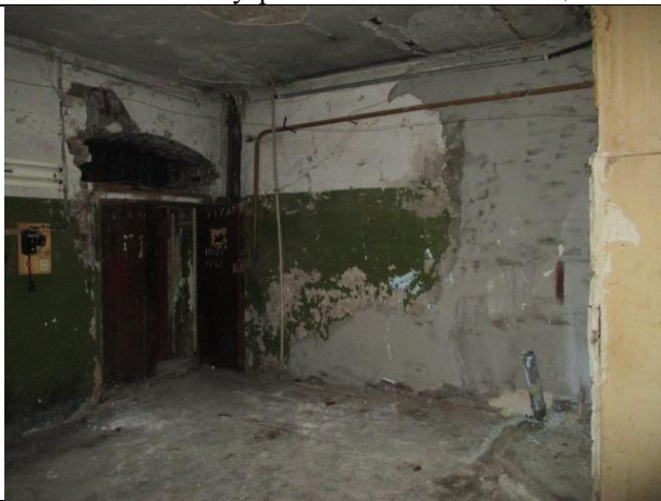
Фото № 11 – Внутреннее состояние помещения
