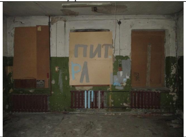
Фото № 12 – Внутреннее состояние помещения
