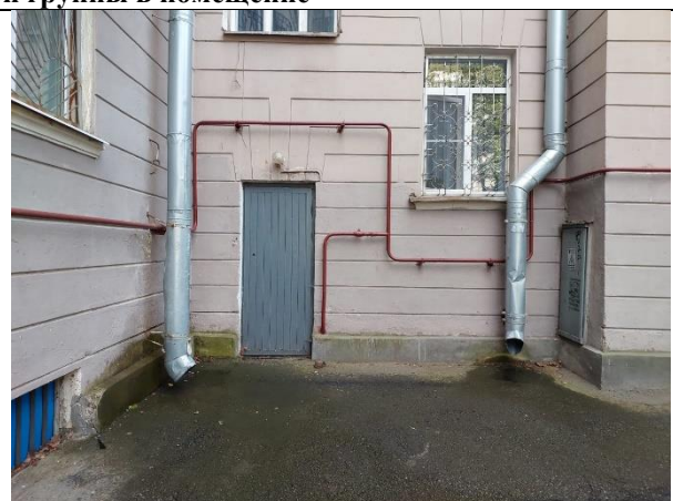
Фото 6. Общий вход Объекта оценки со двора
