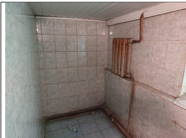
Фото 15. Внутреннее состояние Объекта оценки
