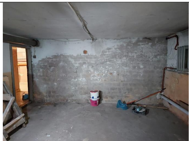
Фото 16. Внутреннее состояние Объекта оценки
