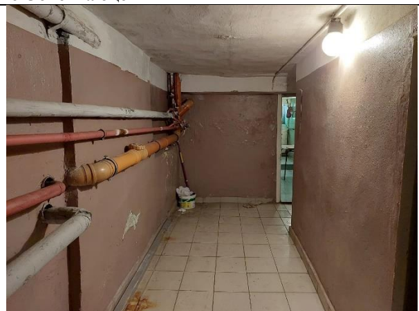
Фото 12. Внутреннее состояние Объекта оценки
